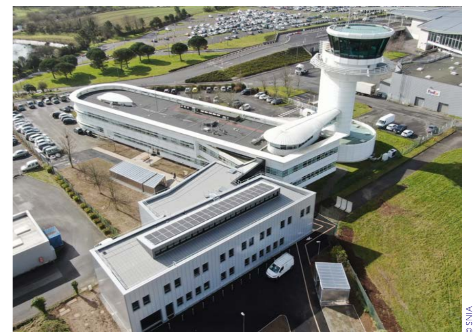
Vue aérienne de l'extension du siège de la DSAC Ouest (au 1 er plan), construction Haute qualité environnementale
