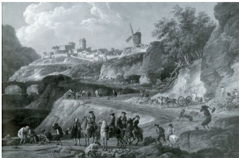
La construction d'une route par Joseph Vernet.
