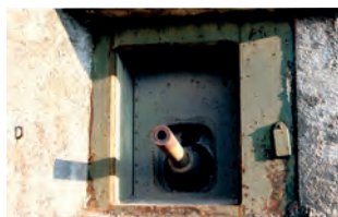
Extérieur et intérieur de casemate de 75m/m
