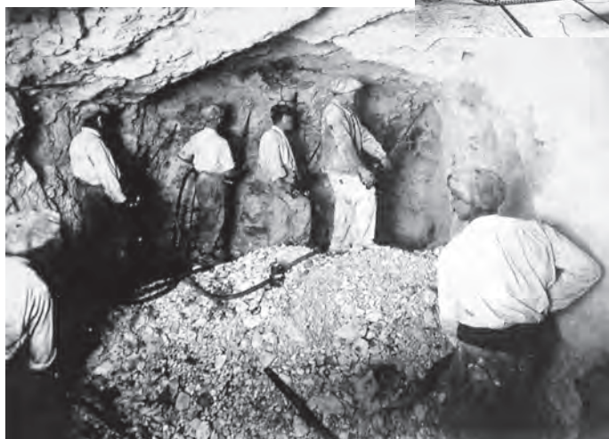
Perforatrices pneumatiques à percussion actionnées par air comprimé.
