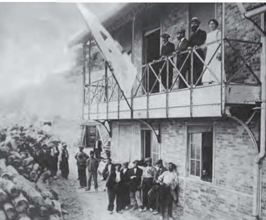
Entreprise Chagnaud. Service médical conduit par le docteur Massad.
