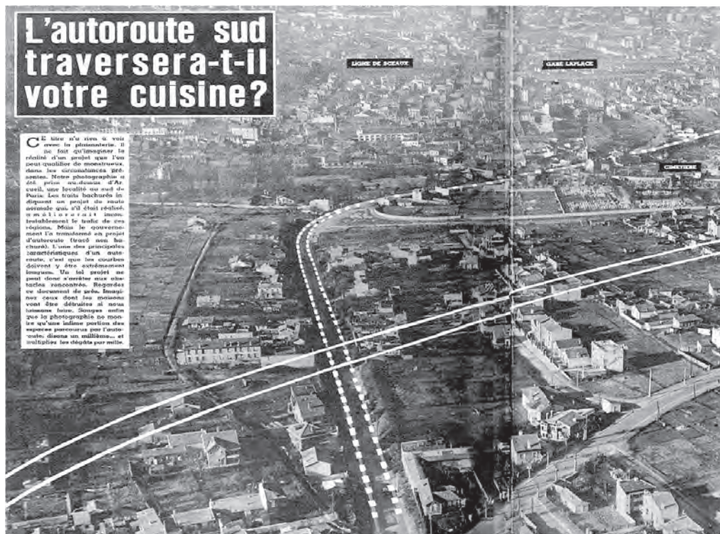
Photomontage du magazine « Regards » (PCF) Décembre 1950. Photo aérienne au-dessus du « lotissement du Plateau », à Arcueil
