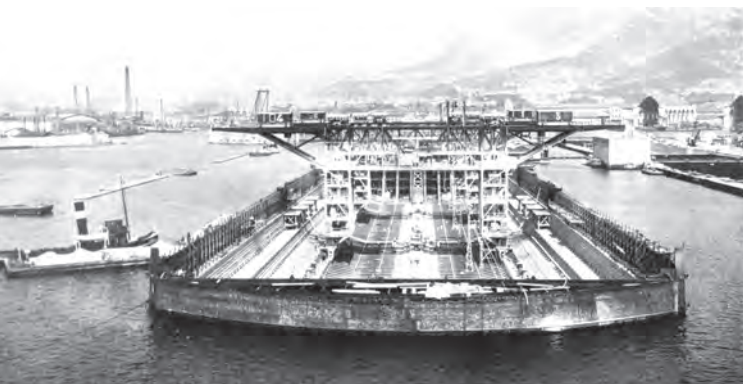
Grand bassin Vauban sud-ouest de Toulon en construction. La masse du radier et des bajoyers est en cours de construction, à l'abri de l'enceinte étanche de charpente métallique. Les revêtements seront posés après complet échouage de l'ensemble. Les terre-pleins seront ultérieurement remblayés.
