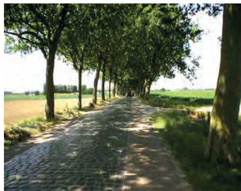
Aux Pays-Bas, l'utilisation de pavés de couleurs différentes donne l'illusion d'une voie de circulation unique, obligeant cyclistes et automobilistes à la vigilance et à la prudence © CROW
