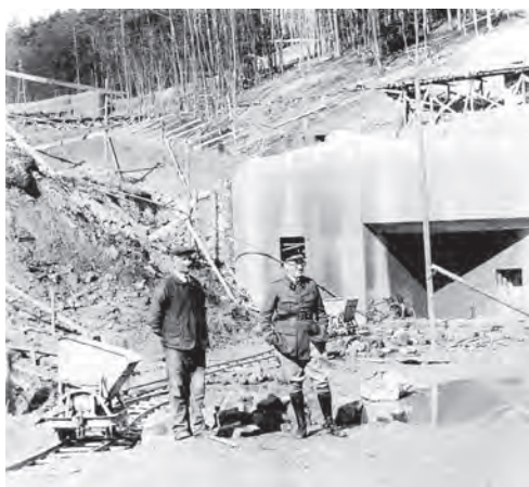
Travaux avec officier
