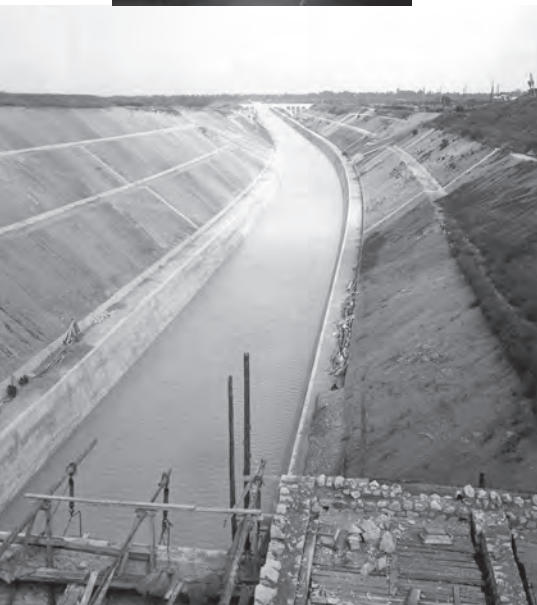
Mise en eau du souterrain fluvial du Rove et de la tranchée de Gignac en mai 1926.
