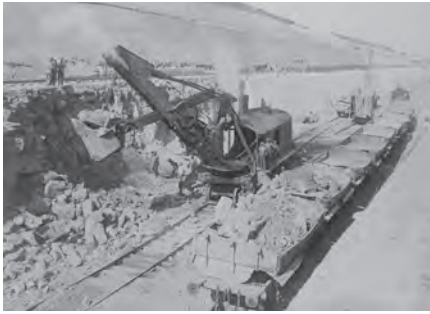
Tranchée de Gignac. Pelle américaine Bucyrus de 70 tonnes de l'entreprise Chagnaud en action.
