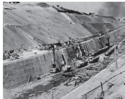
Tranchée de Gignac. Construction des derniers éperons de renforcement.
