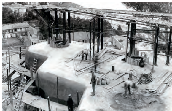
Travaux cap Martin
