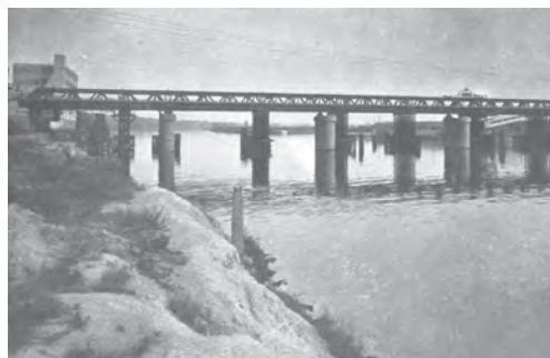
Viaduc d'Argenteuil après reconstruction
