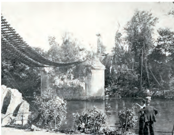
Viaduc de Nogent détruit
