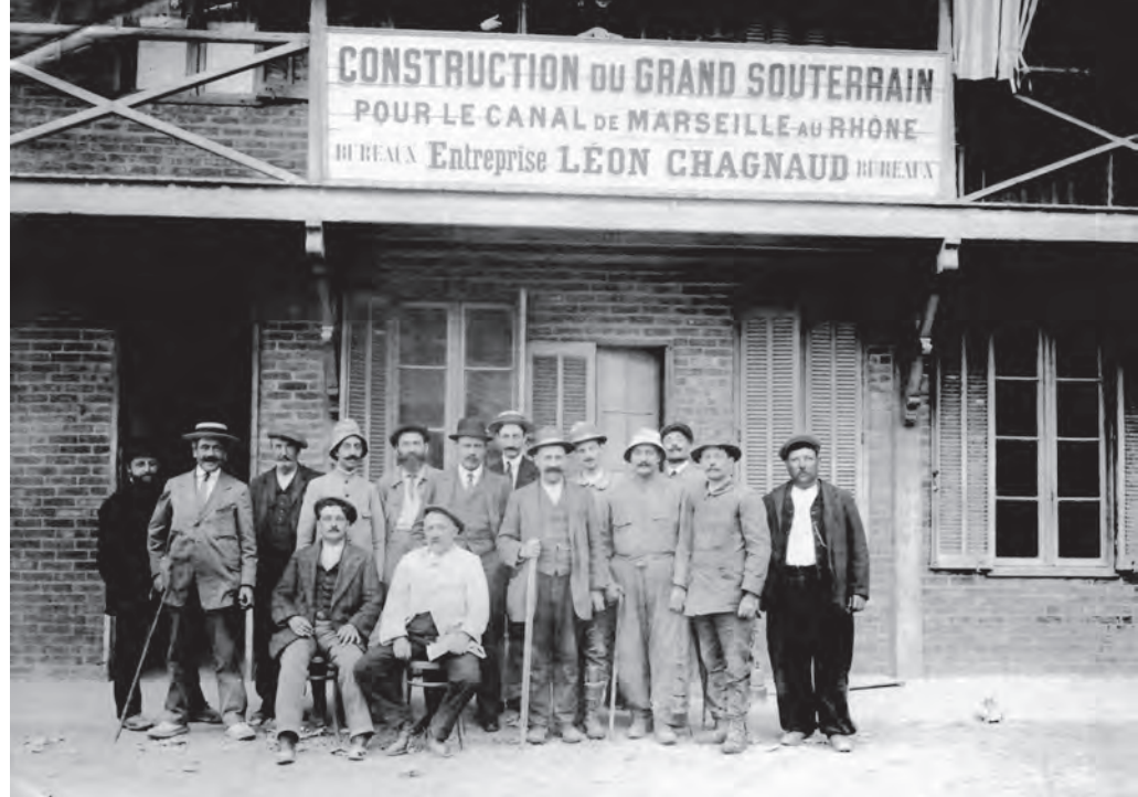
Une des équipes travaillant au souterrain du Rove pose devant les bureaux de l'entreprise, à l'Estaque.
