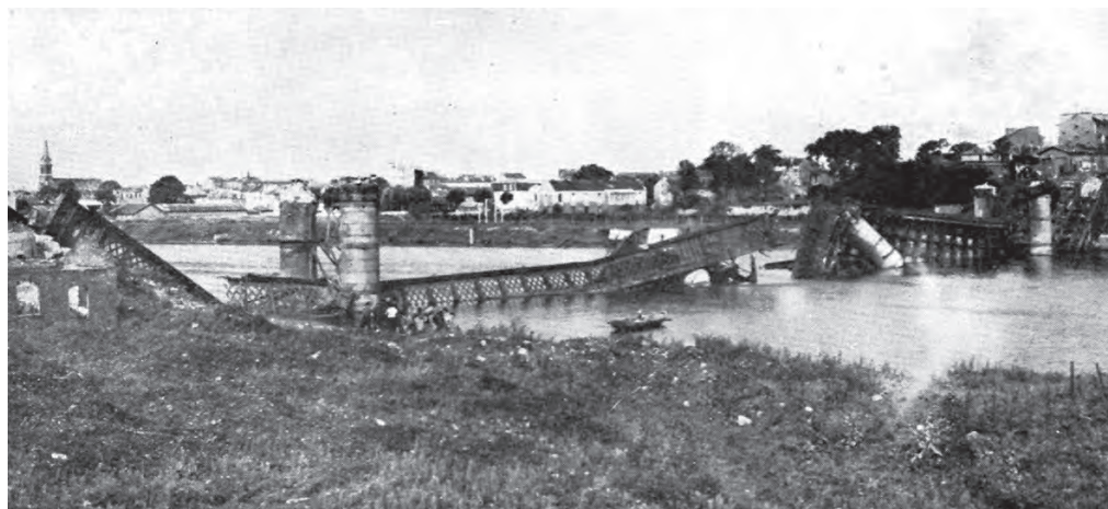
Viaduc d'Argenteuil détruit
