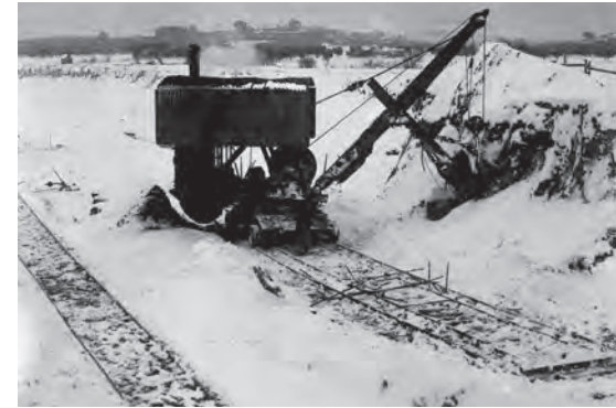
Tranchée de Gignac en janvier 1914, une pelle à vapeur sous la neige.
