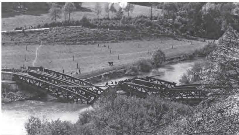
Pont de chemin de fer détruit, mai 1940.
