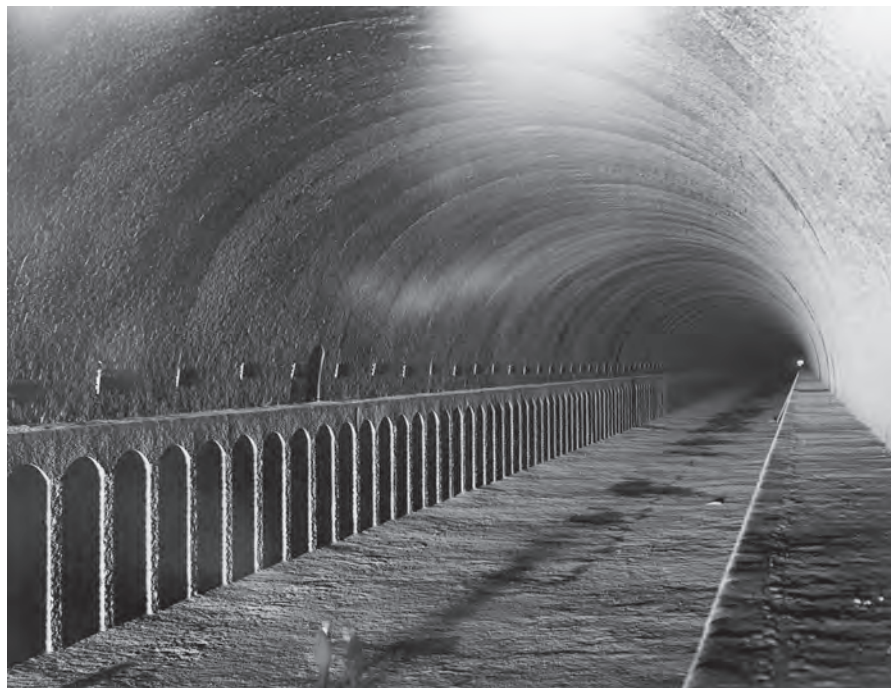
Le souterrain du Rove entièrement achevé juste avant sa mise en eau ; des dimensions exceptionnelles avec 22 mètres de large et 15,4 mètres de haut.
