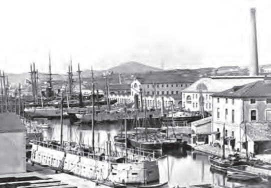
Darse de Castigneau de l'arsenal de Toulon. La nouvelle darse, mise en service vers 1856, est bordée par les ateliers de fonderie, de machines et d'ajustage.
