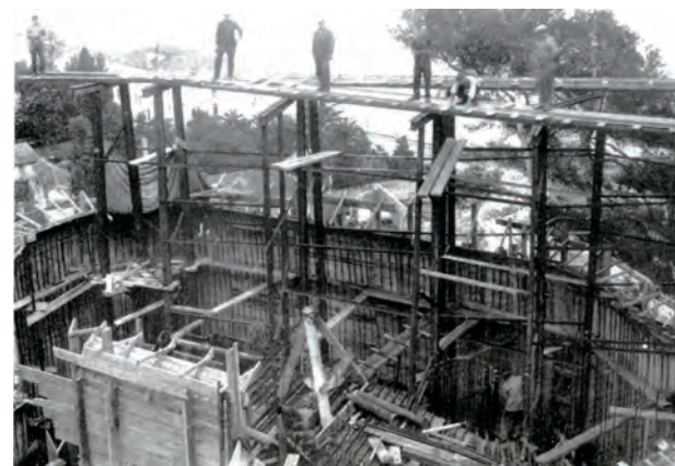
Vue du chantier de Cap Martin après coulage du béton
