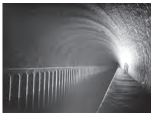
Le souterrain du Rove est mis en eau en mai 1926 à l'issue de quinze ans de travaux.
