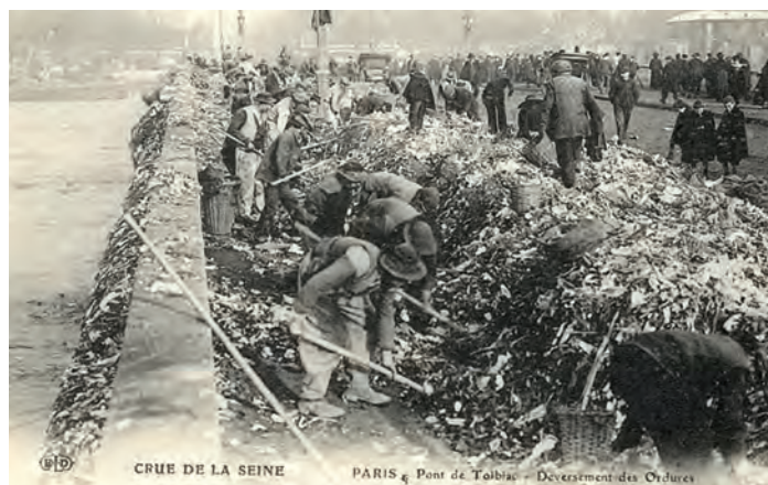
Paris- déversement des ordures pont de Tolbiac
