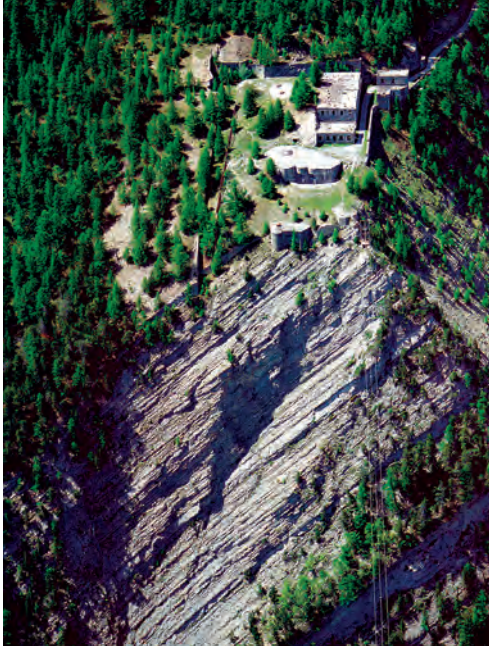
Ouvrage de Roche Lacroix face au col de Larches
