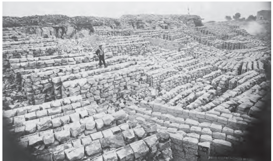
La carrière de Cassis approvisionne en moellons les chantiers du Rove.
