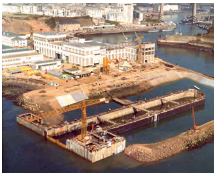
Construction du bassin 10 dans l'arsenal de Brest, 1972.
