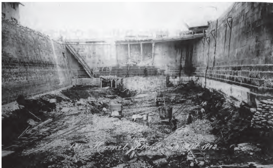
Travaux de la grande forme du Homet en 1912 (Service historique de la défense, antenne marine de Cherbourg). Commencés en 1909, les travaux de la forme du Homet visent à doter le port militaire d'un ouvrage capable d'accueillir des navires longs de 250 mètres. La quasi-totalité de la forme est gagnée sur lamer, à l'abri de batardeaux et/ou de caissons métalliques. Terminée en 1917, la forme accueillera le cuirassé Jean Bart en 1945.
