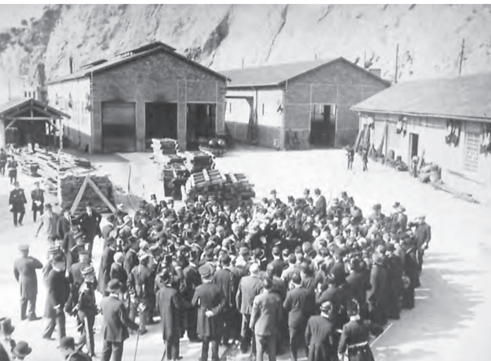
Souterrain du Rove, le 13 octobre 1913 : le personnel de chantier est présenté au Président de la République Raymond Poincaré, en visite.
