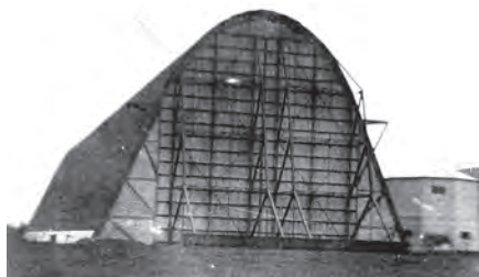
Hangar à dirigeables de Montebourg. Construit en 1919 pour les dirigeables patrouillant en Manche, le hangar est long de 150 mètres et haut de 28. Réalisé en béton armé, il est formé par une voûte parabolique supportée par des chevalements qui assurent le contreventement.
