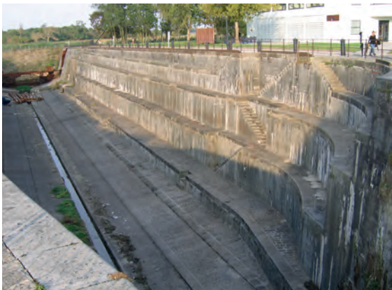
La forme Napoléon III à Rochefort. Le bateau-porte pétardé par les Allemands au printemps 1945 a favorisé l'envasement de l'ouvrage. Complètement dévasé il y a quelques années, c'est un point fort du site de l'arsenal-musée de Rochefort.
