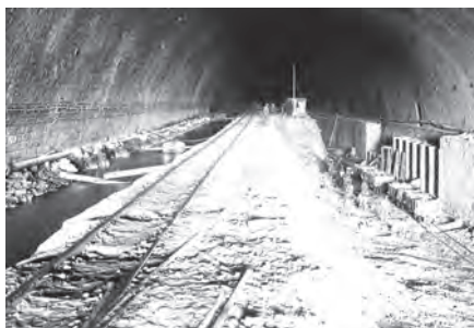
Evacuation des déblais du souterrain du Rove (à droite) et système de pompage en action (à gauche).
