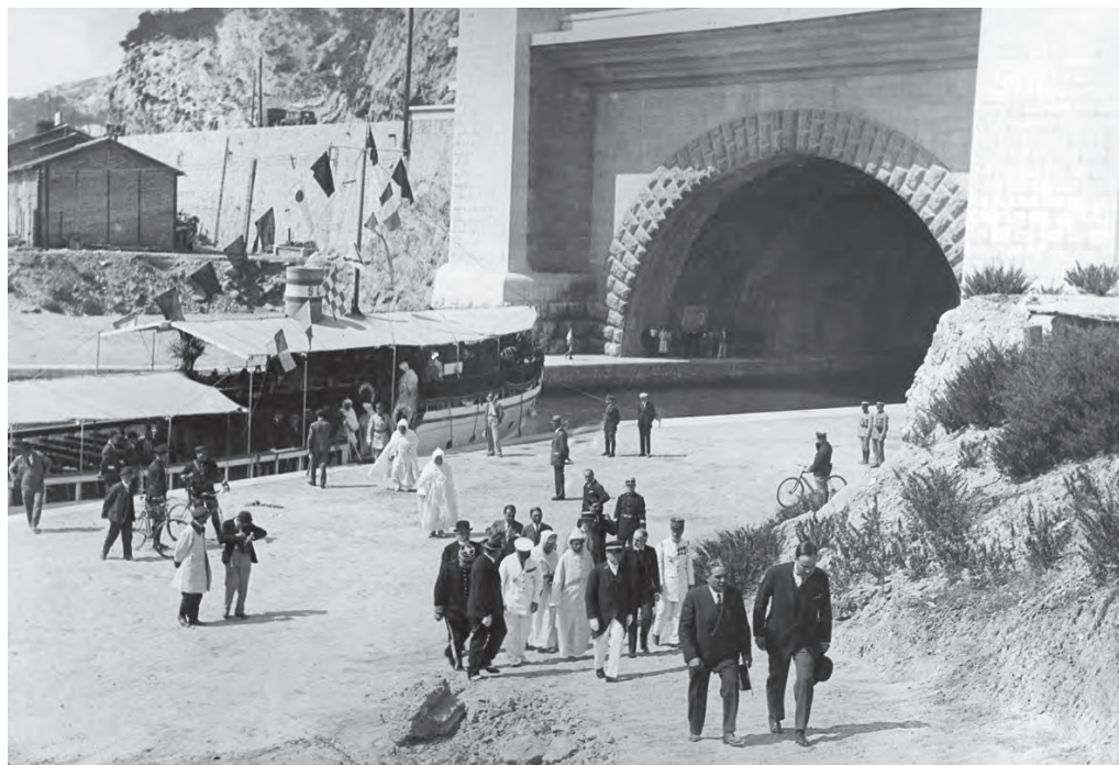
Le Sultan du Maroc visite le souterrain du Rove en septembre 1931.
