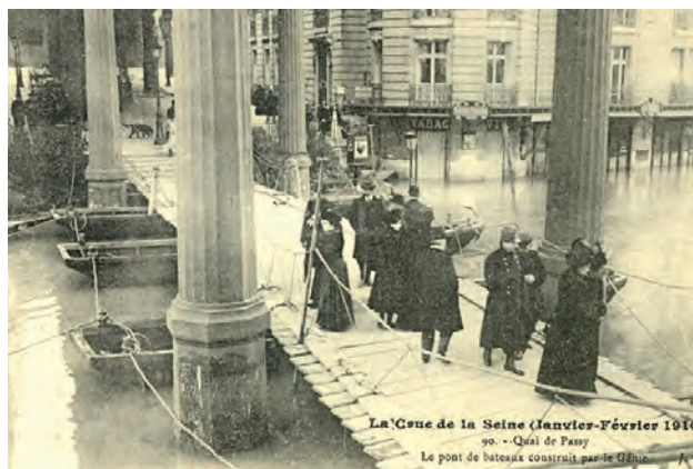
Le pont de bateaux construit par le Génie
