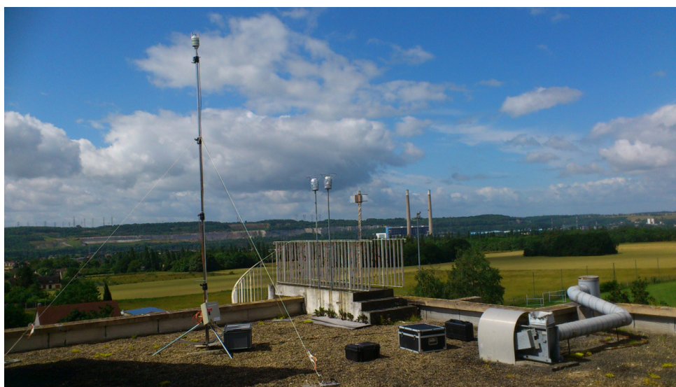
Figure 31 : Station météorologique mise en place pendant une campagne de mesures – Mât de mesure de 10 m
