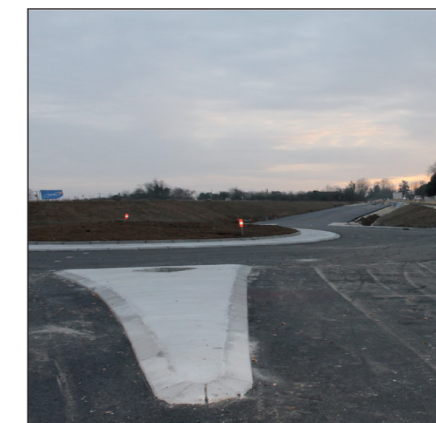
Aménagement d'un carrefour giratoire sur la RN 141 sur la commune de Chaniers (17)
