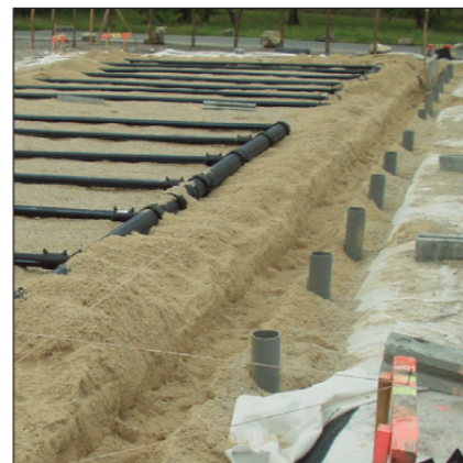
DIR Atlantique – réhabilitation d'un bassin de traitement des eaux
