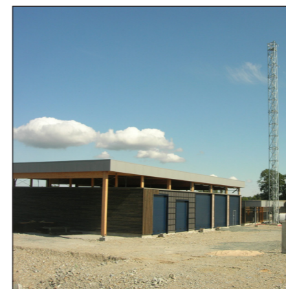
Construction du CEI de Gouzon
