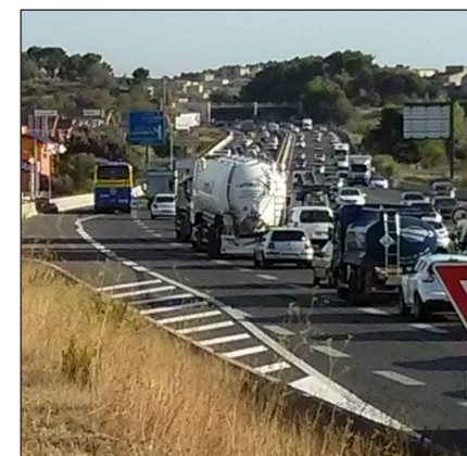
Création de la Voie réservée sur l'A51
