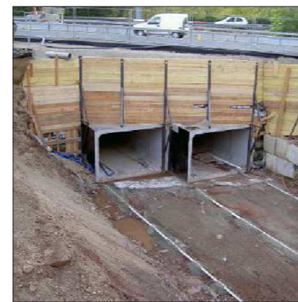
A75 – Remplacements d'ouvrages hydrauliques effondrés à Lodève (DIR Massif Central 2015)
