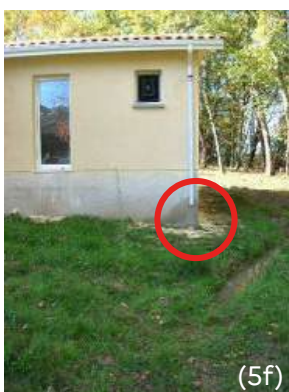
Figures 4 : Conséquences de la mauvaise gestion de l'eau sur terrain argileux (crédits photos 5b à 5d et 5e2 ©L. Ighil Ameur ; crédit photo 5e1 ©Debenne, 2022, crédit photos 5f ©AF Bechade).
