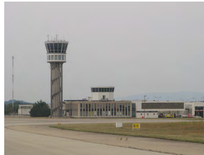
Installations de la Navigation aérienne en 2005.
