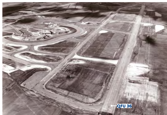
Avancement des travaux fin 1974 : les deux Terminaux de l'aérogare (photo en haut) et la piste avec ses taxiways (photo en bas) prennent forme. Des travaux qui seront exécutés dans le planning prévu !
