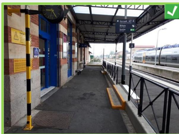
Dispositif de protection par garde-corps pour éviter le risque de chute.
