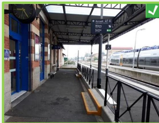
Implantation d’un garde-corps pour éviter le risque de chute.
