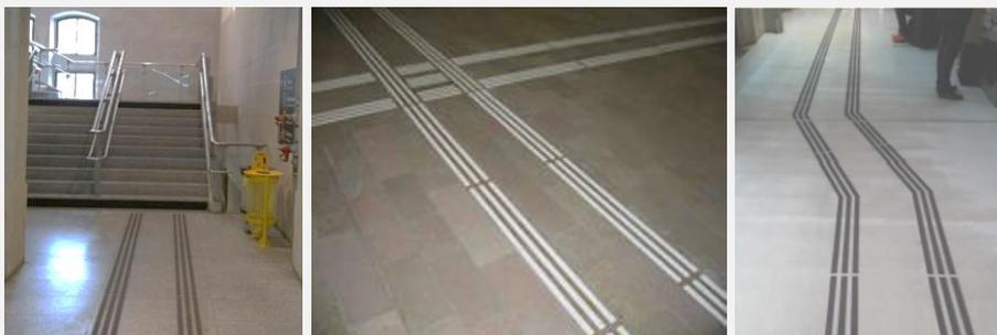
**LES BANDES DE GUIDAGE SIMPLES** sont composées d'un module unique constitué de quatre nervures.
