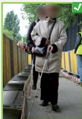
Dispositif de détection pour éviter les chutes sur les pieds des clôtures.
