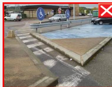
Panneaux non conformes, marquage effacé et place non raccordée au cheminement.
