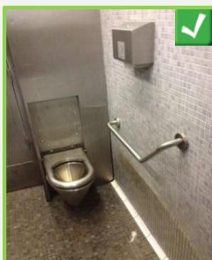
Barre d'appui conforme à la réglementation et à l'usage (barre coudée).
