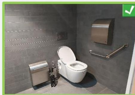
Barre d'appui conforme à la réglementation et à l'usage (barre coudée).
