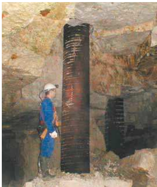
Exemple de pieux traversant une carrière (INERIS)
