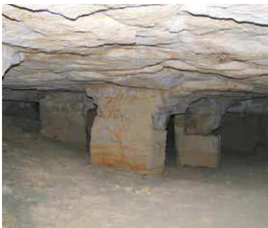
Ancienne exploitation par chambres et piliers (INERIS)
