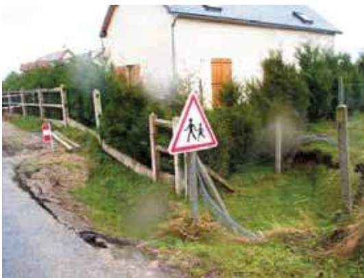
Exemples d'affaissements en surface – souterrain refuge (INERIS) et marnière (CETE Normandie-Centre)
