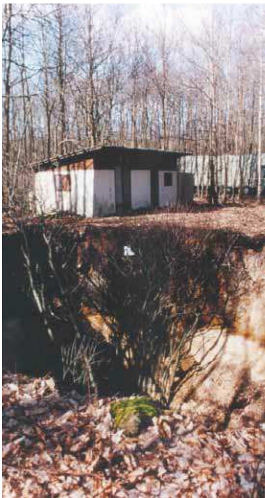
Conséquences d'un fontis en surface (INERIS)
