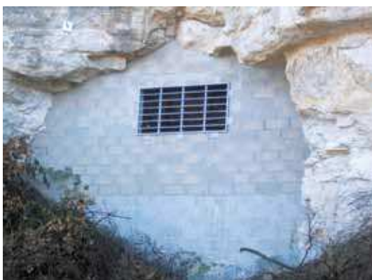
Aménagement d'un passage pour les chiroptères
