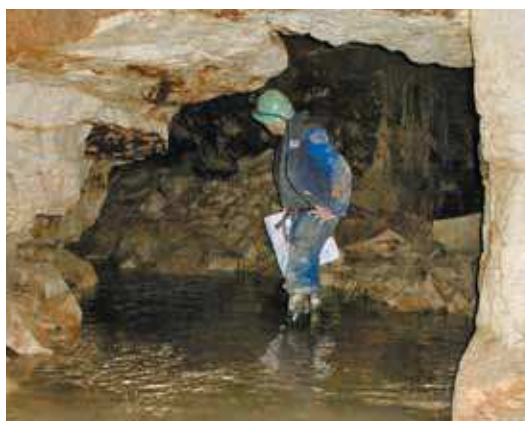
Facteurs pouvant favoriser la dégradation rapide de galeries (racines-eau) (INERIS)
