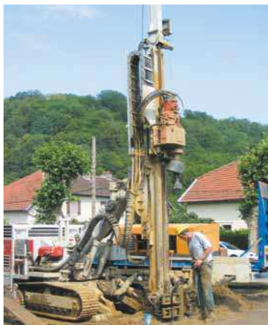
Exemple de chantier de reconnaissance (INERIS)
