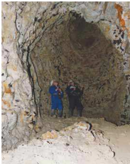
Développement d'une cloche de fontis (INERIS)
