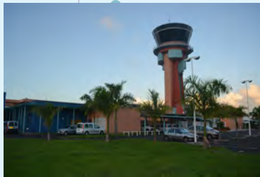
Pointe-à-Pitre control tower
