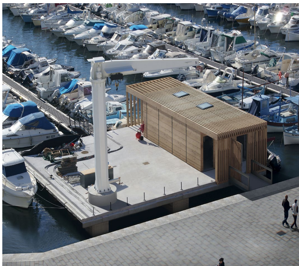
Les pavillons nautiques du Vieux-Port de Marseille ont été habillés d'un bardage de chêne.
