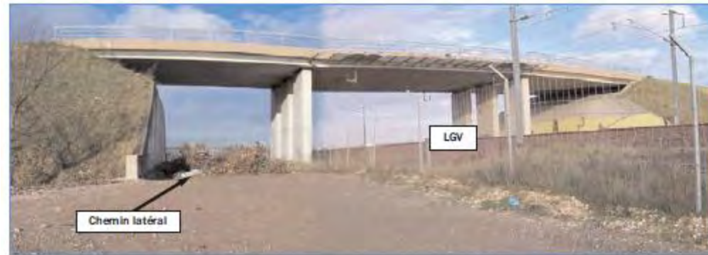
Photographie 1 : vue sur le pont actuel de la RD 84 au-dessus de la LGV.
