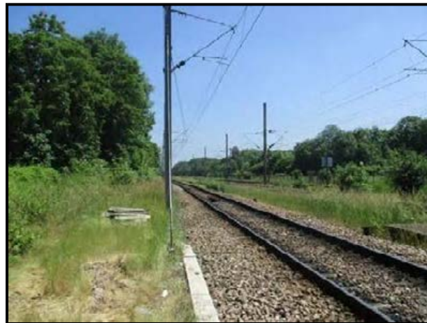
Photo 37 : Voie ferrée traversant un espace boisé (Rainette)
