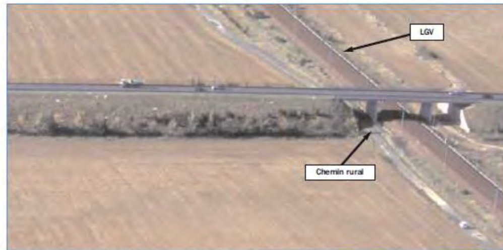
Photographie 2 : vue sur le pont de la RD 84.
