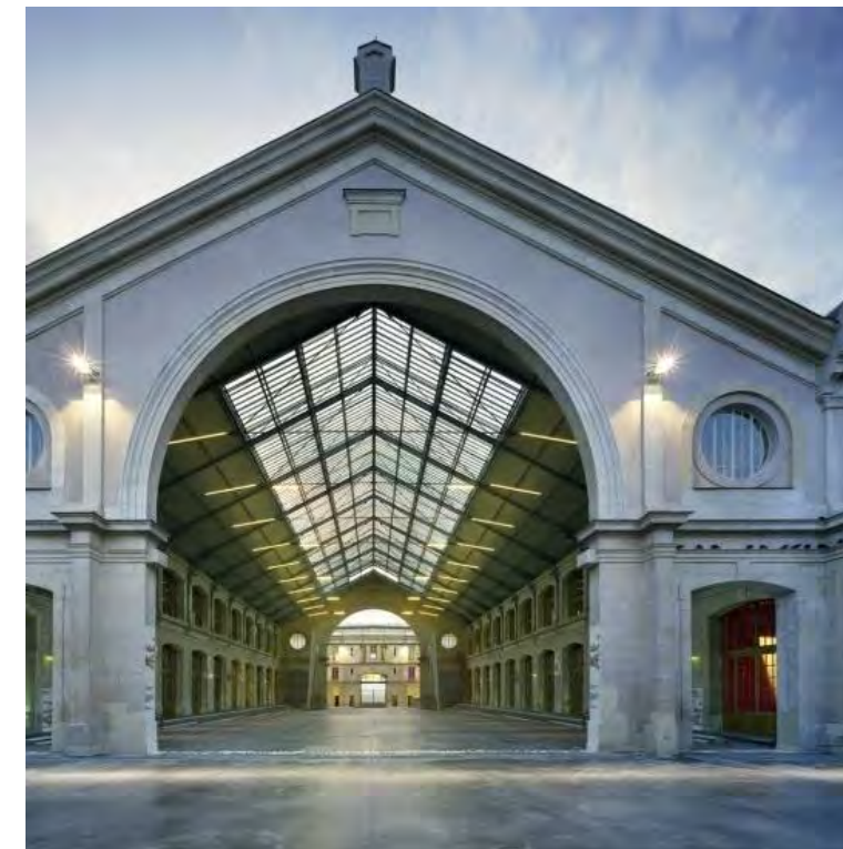
Figure 117 : Centquatre-Paris (aussi appelé « Service municipal des Pompes Funèbres ») Façades et toitures sur rues des bâtiments donnant sur les rues d'Aubervilliers et Curial ; halles en totalité avec leurs cours : inscrit aux monuments historiques par arrêté du 21 janvier (source : www.tourisme93.com )
