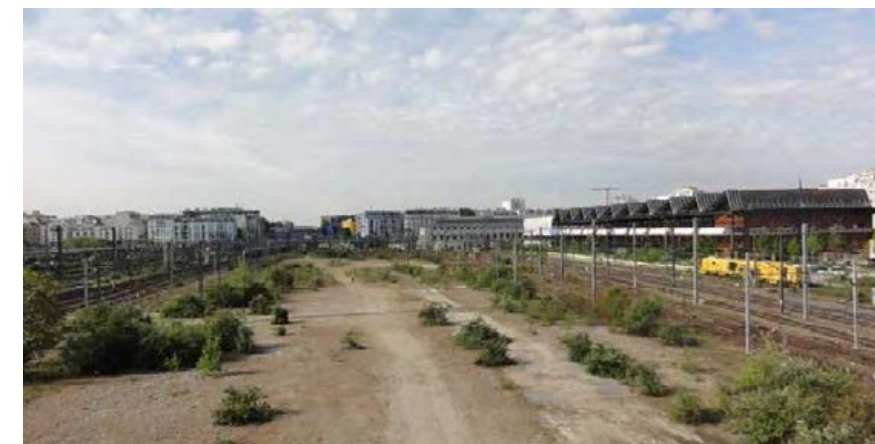
Figure 105 : Vue depuis le site ferroviaire de la Chapelle, halle Pajol à droite de l'image (source : Ingérop 2017)
