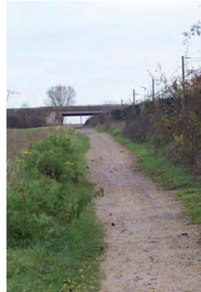
Figure 122 : Sentier pédestre non balisé en bordure de la voie ferrée à Mitry-Mory
