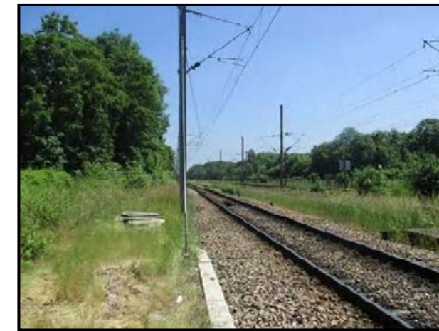
Photo 36 : Voie ferrée traversant un espace boisé (Rainette)
