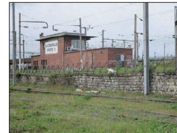
Photo 17 : Bâtiment, Zone D (Rainette, 2016)
