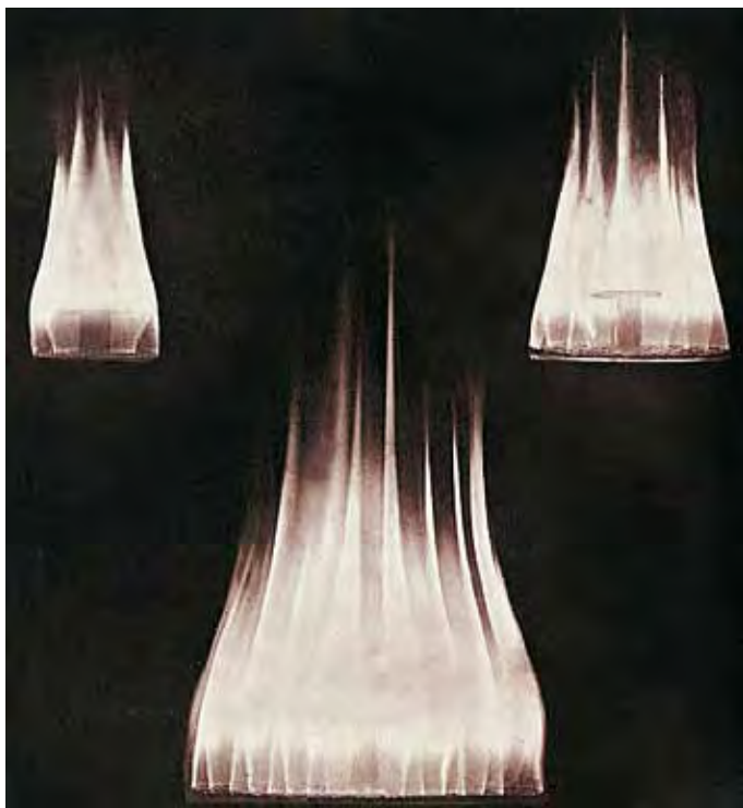
Pour augmenter la puissance des lampes à huile, on multiplie le nombre de mèches. In Phares, histoire du balisage et de l'éclairage des côtes de France . Jean-Christophe Fichou, Noël Le Hénaff, Xavier Mével. Douarnenez, Chasse-marée, 2003, p.81
