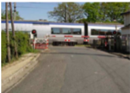
Figure 2 : passage à niveau gardé
