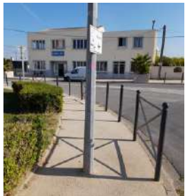
Cheminement aménagé mais inaccessible
