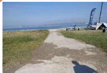
Cheminement de mise à l'eau
