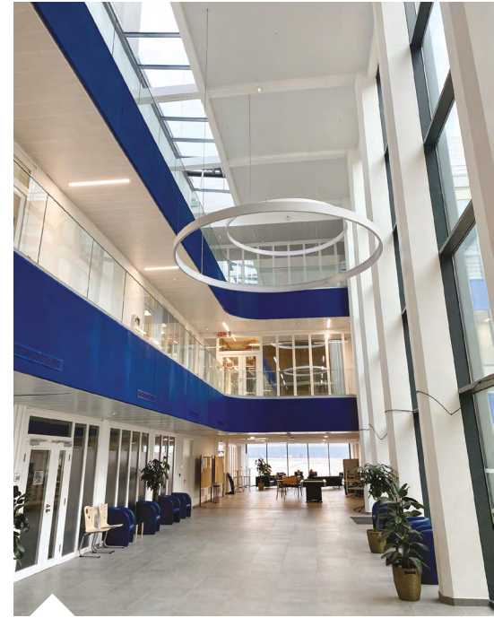
Nouveau bloc technique à Marseille-Provence.
