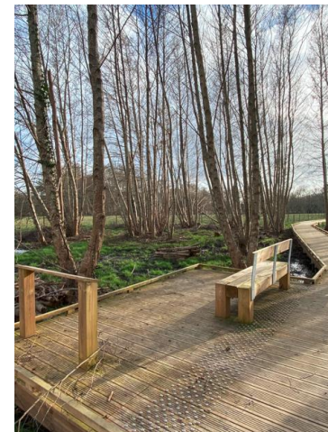
Platelage Allée de Boissière
