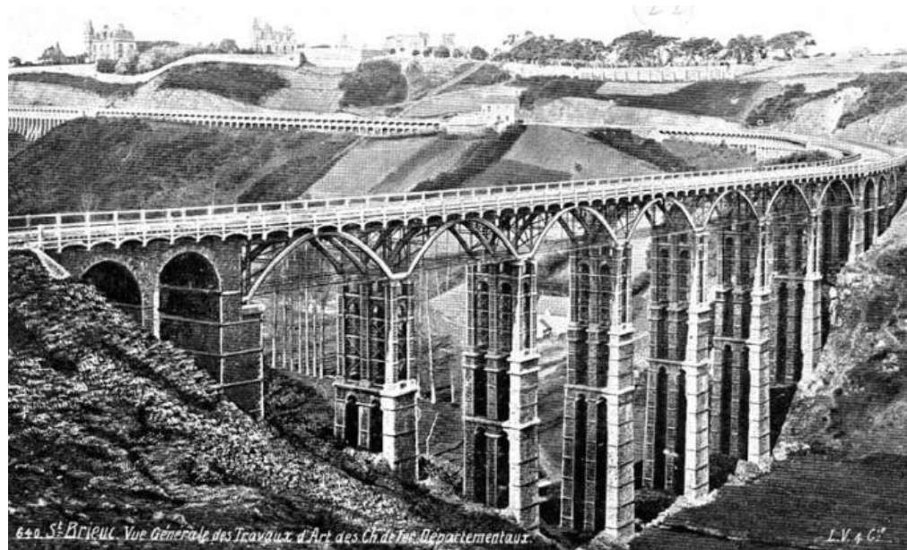
Viaduc de Toupin
