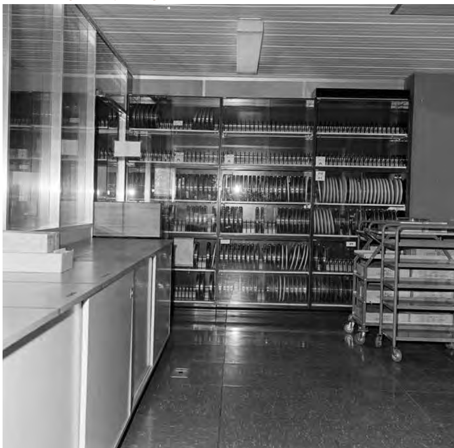
Salle de stockage des disques à Bagneux ©MEEM-MHLD
