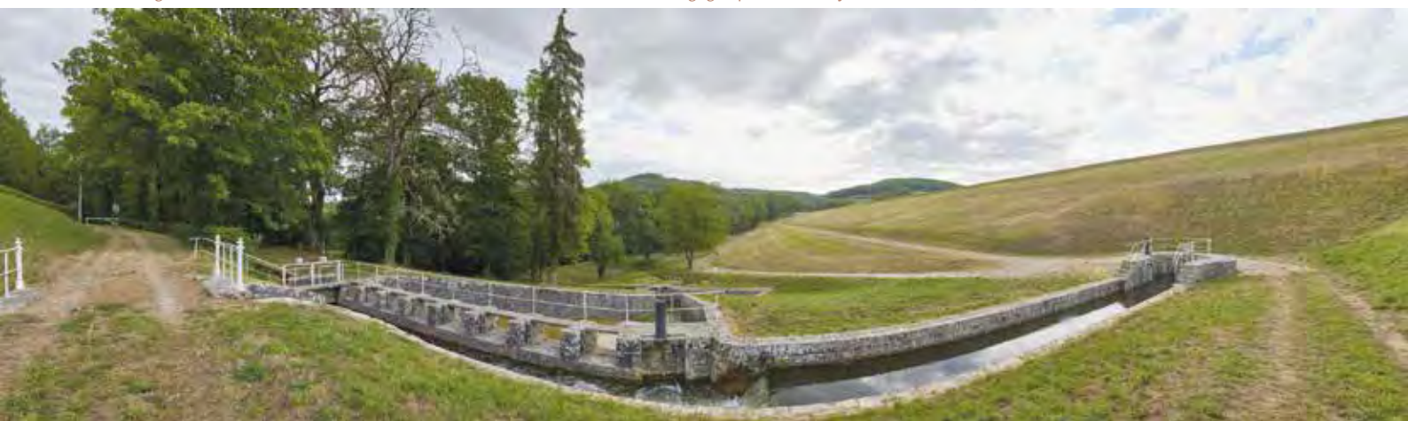
Barrage réservoir et contre-réservoir de Grosbois alimentant le canal de Bourgogne près de Pouilly-en-Auxois © VNF/Damien Lachas
