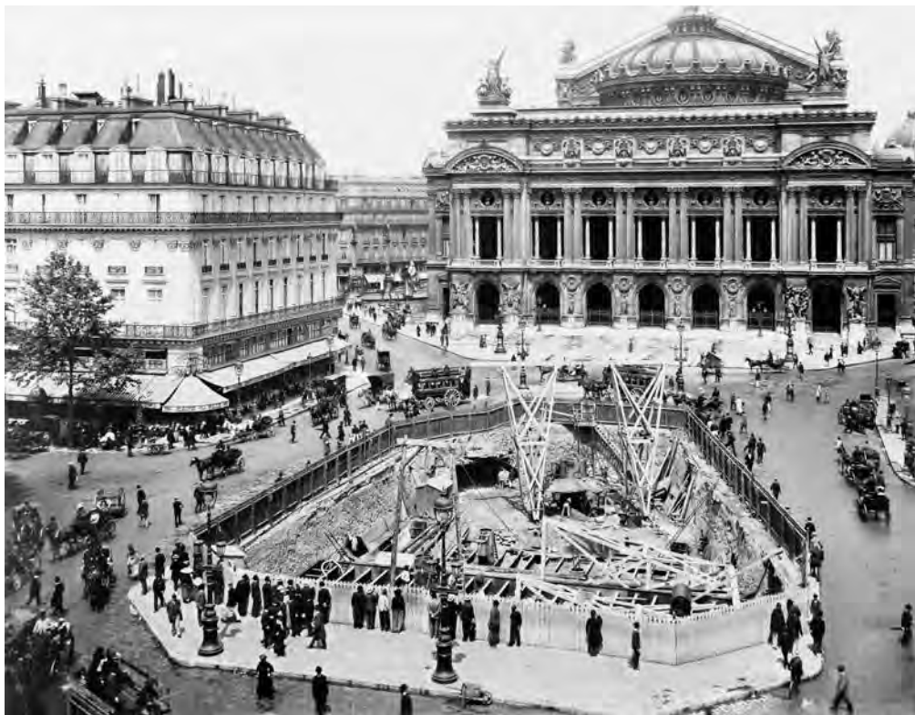
Union photographique française. Place de l'Opéra, chantier de l'ouvrage de superposition des 3 lignes. Vue d'ensemble. 15 juin 1903 | PH 451-12 A.6 © École nationale des Ponts et Chaussées
