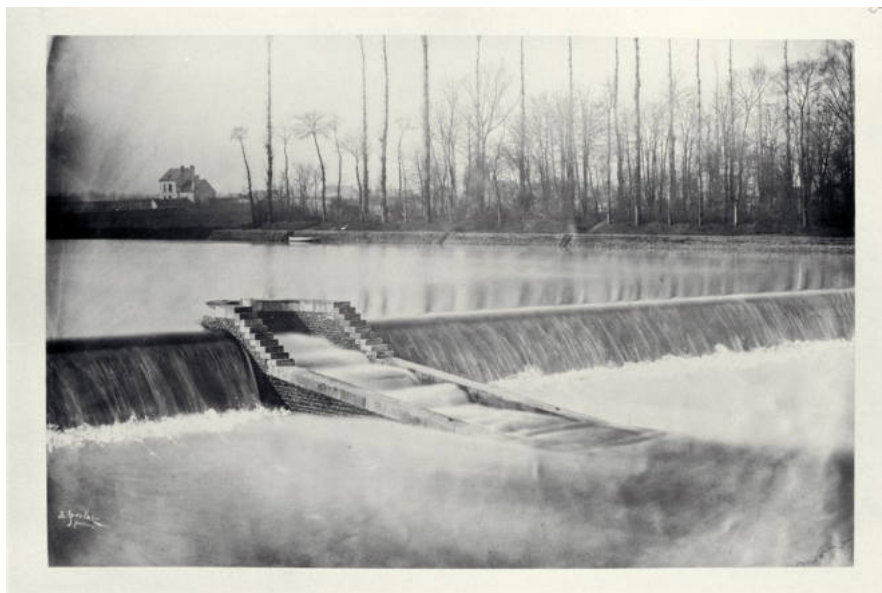
Échelle à saumons sur la Vienne à Châtellerault. Ministère des Travaux publics, vues photographiques Charente-Inférieure, Deux-Sèvres, Vienne, Dordogne ©Duclos, J. - 1873, ENPC.
