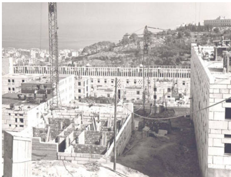
Fig.5 : Vue sur le chantier de la cité «Climat de France» à Alger, F. Pouillon architecte 1955. Source : Archive de l'Institut français d'architecture, Fonds Robert Auzelle.
