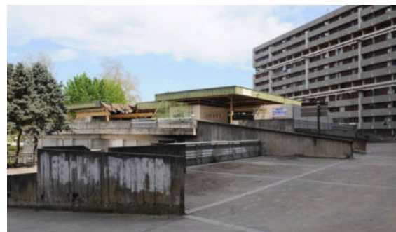
Le Mirail : dalle du Tintoret, démolition de la crèche 2010 ©Ville de Toulouse
