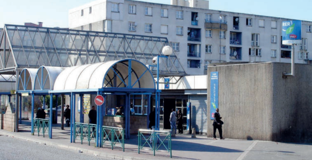
Gare de Sevrans Beaudottes
