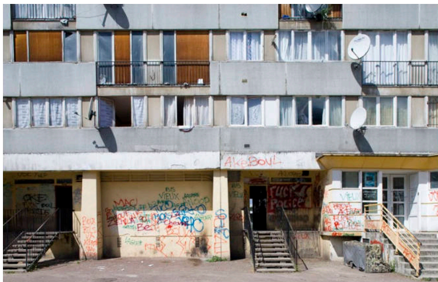
Ségrégation et exclusion n'ont fait que s'accroître dans un environnement longtemps dévalorisé. Sevrans 2008 ©Luc Boegly
