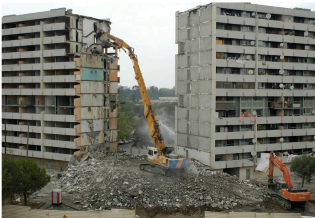
Le Mirail : Démolition de l'immeuble Satie ©Ville de Toulouse
