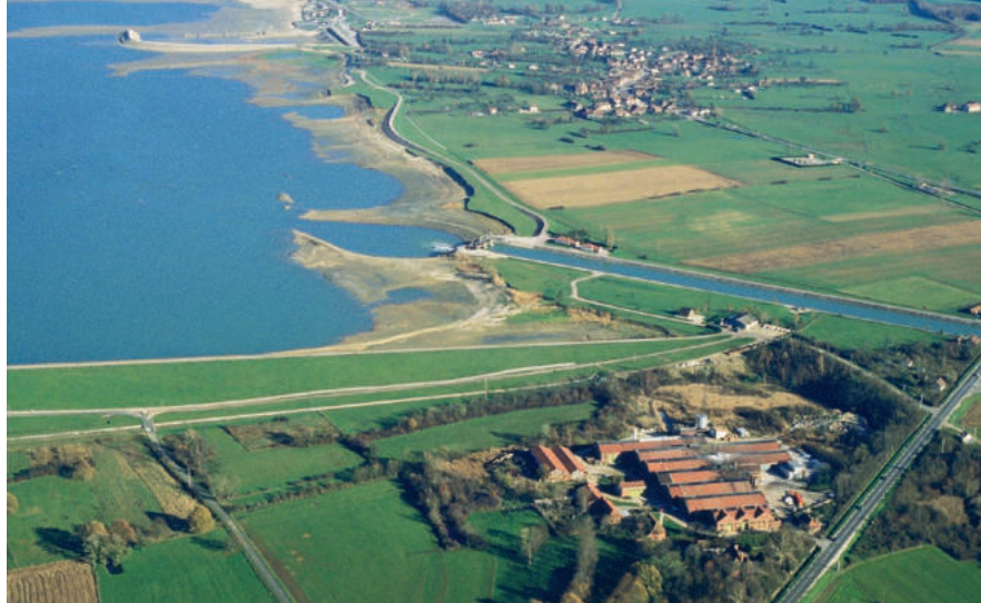
Le réservoir Seine. Déversoir d'extrémité du canal d'aménée. Barrage Seine © DRIEA/Gobry
