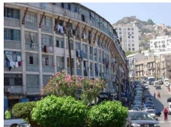
Vue sur façade, immeuble courbe de la cité du « Climat de France » à Alger, F. Pouillon architecte ©Rym Merzelkad, 2010
