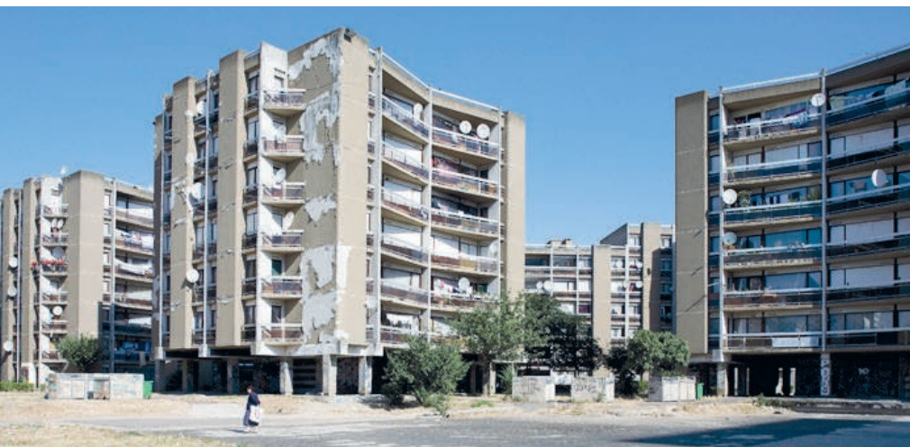
L'accumulation de problèmes différents. Immobilière 3F, Clichy-sous-Bois-Monfermeil, 2008 ©Luc Boegly
