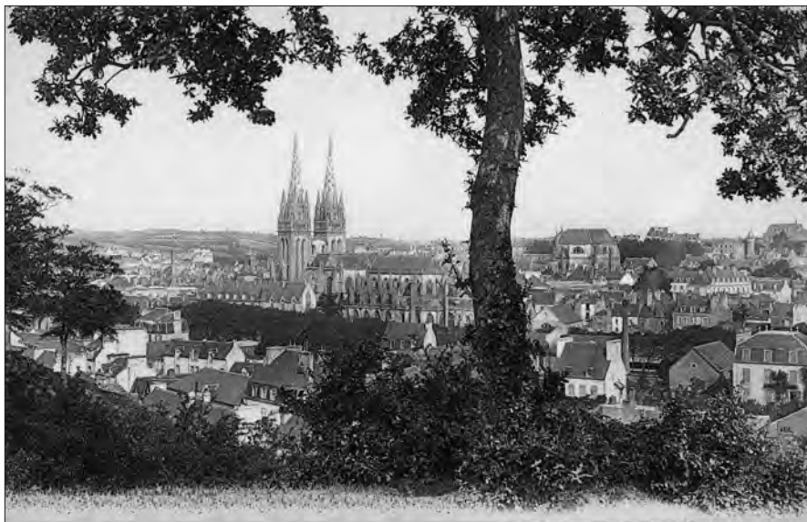
Quimper, vue prise du Mont Frugy. Documents et photos de C.-N. Queffélec (voir annexe)
