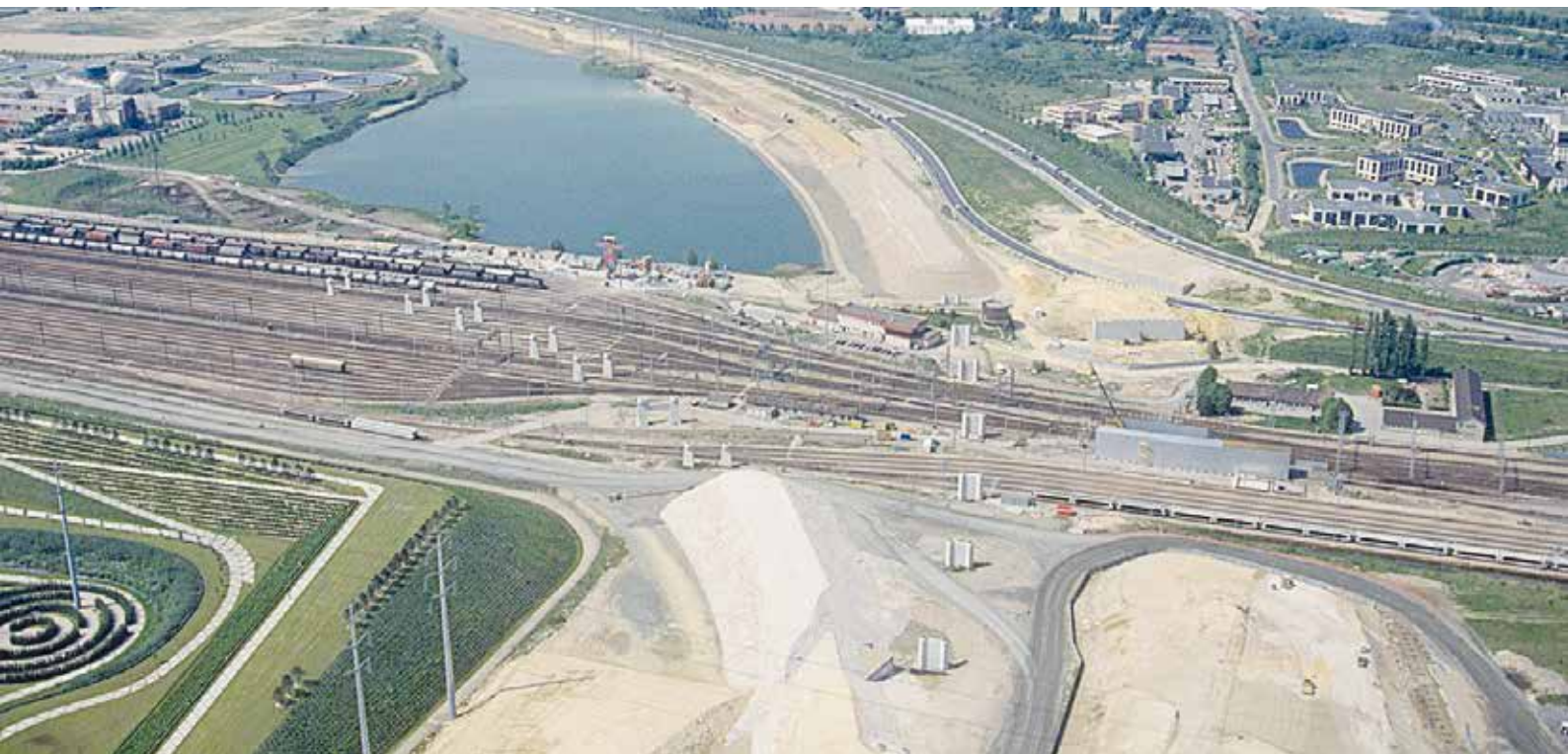
Vue aérienne Valenton, travaux TGV, tracé N6 © DRIEA/GOBRY
