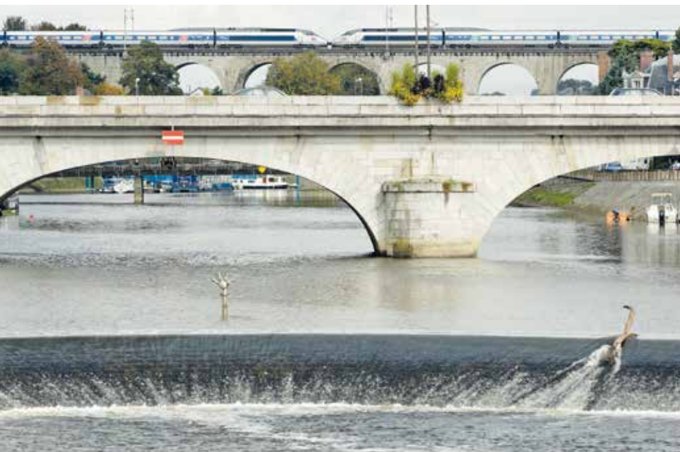
Un TGV passant sur un viaduc au dessus de la Mayenne à Laval © Laurent Mignaux/METL-MEDDE
