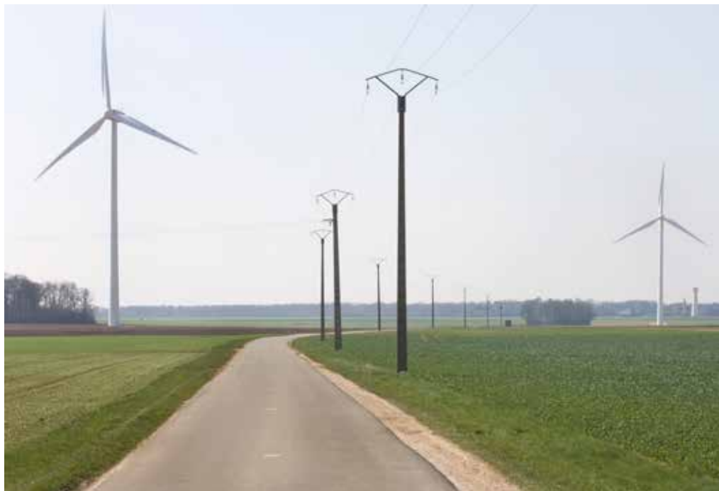
Ligne électrique et éoliennes © Laurent Mignaux/METL-MEDDE
