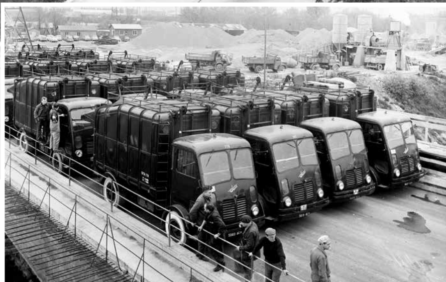
Alignement de camions pour le test de résistance d'un pont à Épinay-sur-Seine @DREIF/MAHE - 1960
