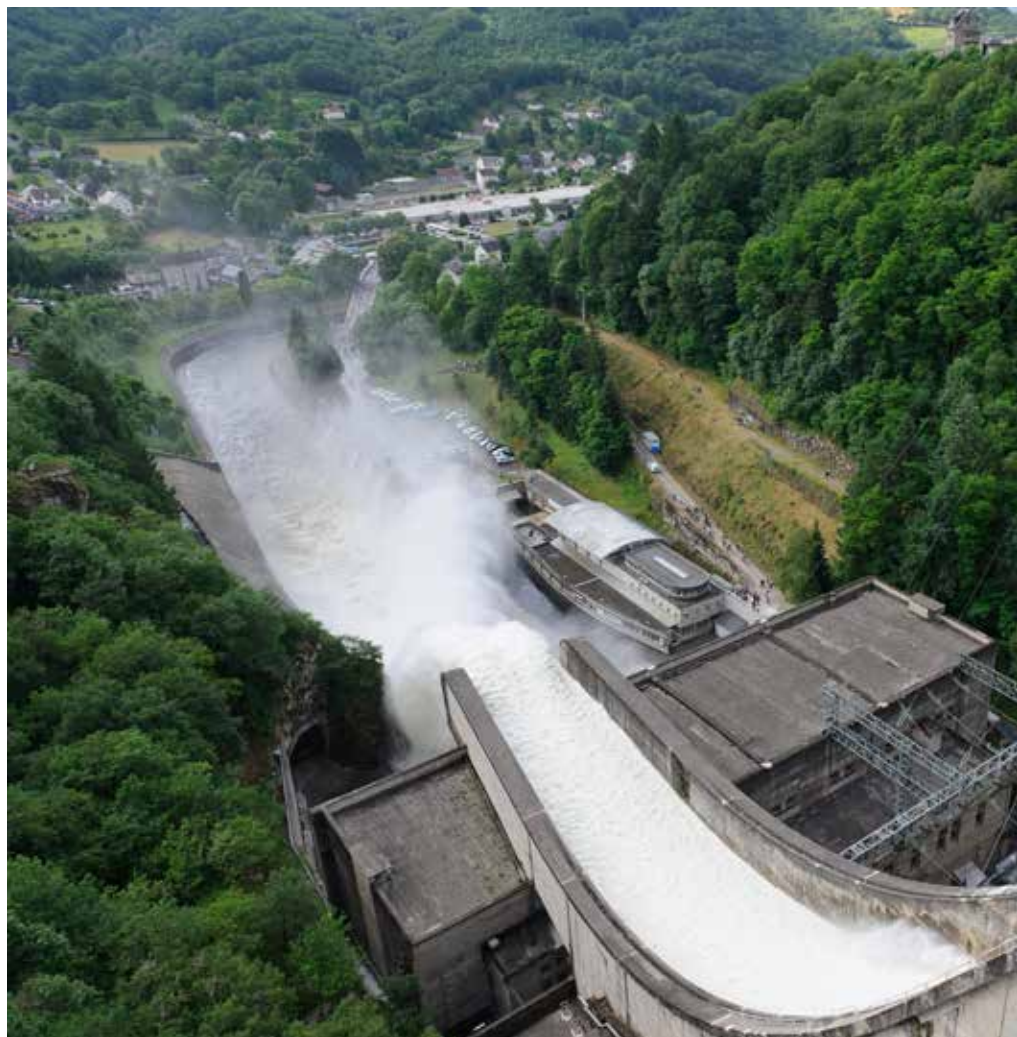
Lâcher d'eau par l'évacuateur de crues au barrage de Bort-les-Orgues © Arnaud Bouissou/METL-MEDDE
