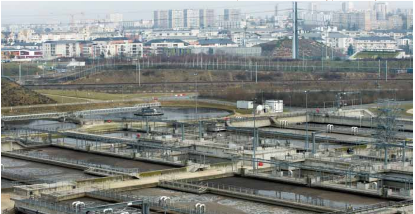
Usine d'épuration de Valenton : bassin biologique © Laurent Mignaux - MEDDE
