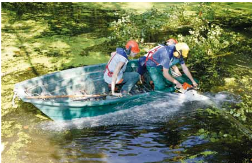
Travaux d'entretien de rivière, retrait d'embâcle faisant obstacle à l'écoulement des eaux © Thierry Degen - MEDDE
