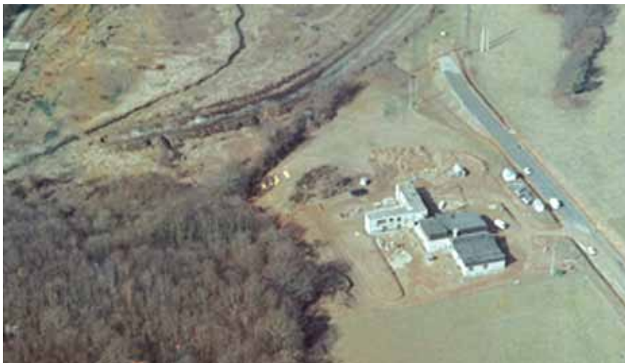
Construction du bâtiment en 1977 à la Souterraine ©OIEau
