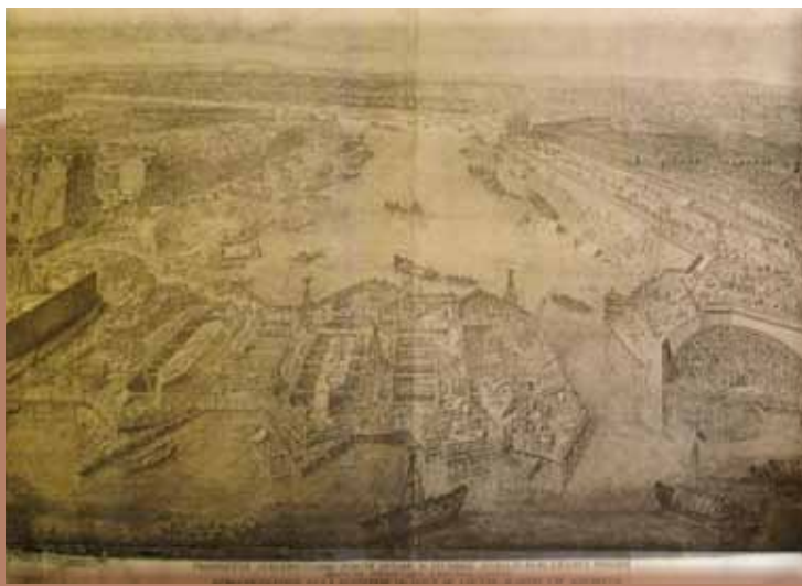
Construction des arches du pont Royal, gravure de Liévin Cruyl, 1687, ibid. 7
