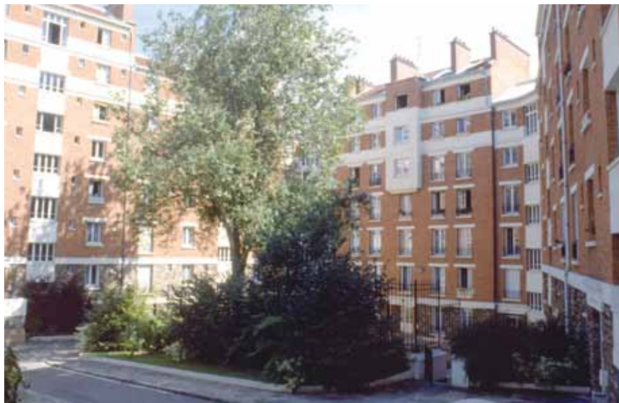
Réhabilitation de 224 logements HBM en briques rouge, 50 Bd Serrurier - Paris XIX e OPAC de Paris ©DRIEA/Gauthier
