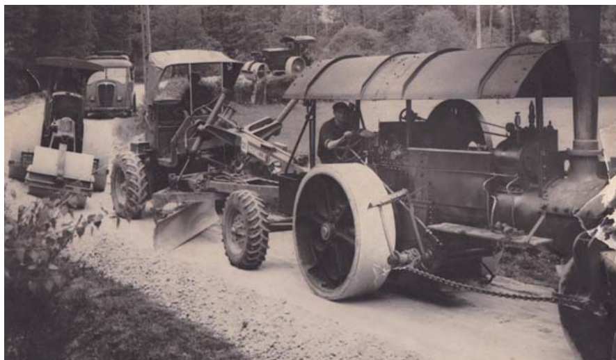
Chantier d'empierrement (cylindre à vapeur, niveleuse Rhonelle, cylindre Five-Lilles, tonne à eau) Source - Parc de la Haute-Vienne
