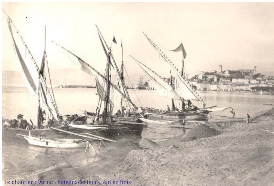
Le chantier d'Arluc : bateaux-levés, épi en bois
