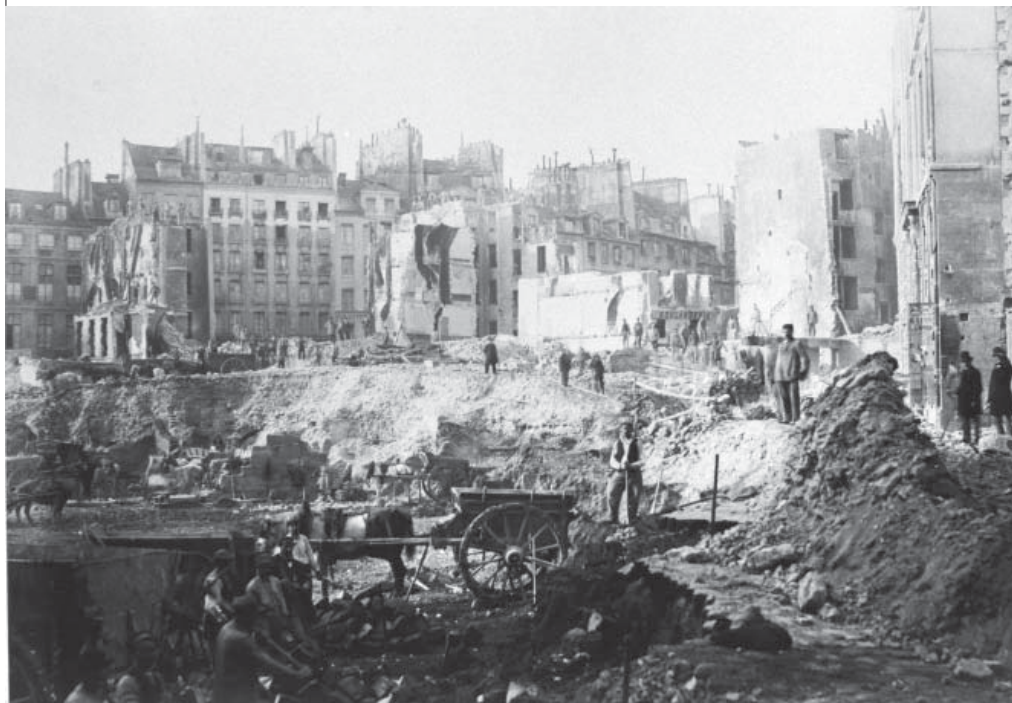
Avenue de l'Opéra – Chantier de la Butte du Moulin et de la rue Saint-Roch. Photographes Marville, Charles - ©École des Ponts ParisTech
