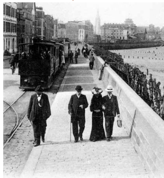
Le sillon et l'arrêt du tramway à Saint-Malo
