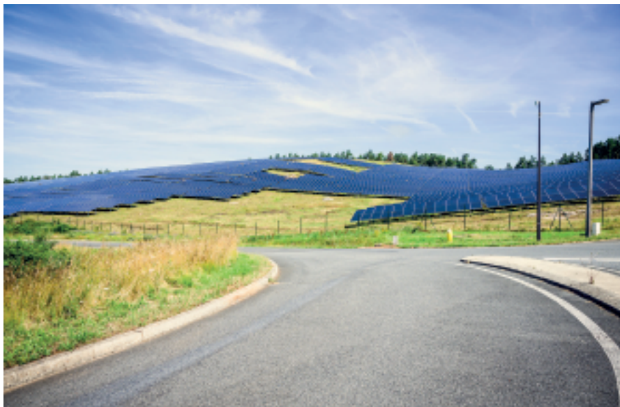
Centrale solaire photovoltaïque de La Tieule (Occitanie), 2024 © Manuel Bouquet, TERRA
