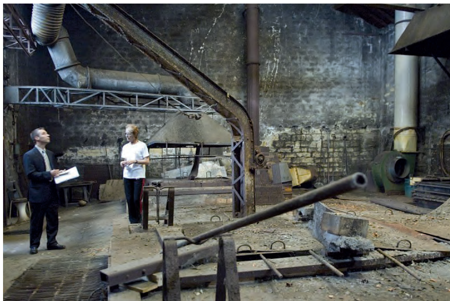
Visite d'inspection. ©L. Mignaux/MEDDTL
