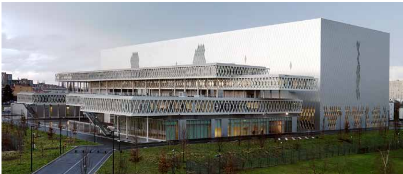
Centre des Archives nationales de Pierrefitte-sur-Seine (arch. M. Fuksas, 2012) © Ministère de la Culture
