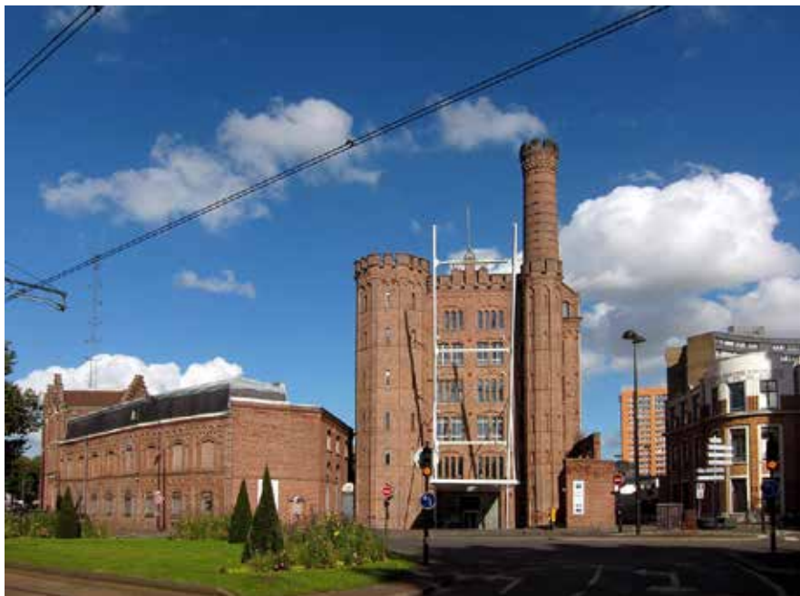
La Motte Bossut est une ancienne filature de coton, réhabilitée elle abrite le Centre des Archives nationales du monde du travail. Les bâtiments donnant sur le boulevard Leclerc sont eux aussi réhabilités et accueillent aujourd'hui le Téléport et le Centre International de la Communication. © DR
