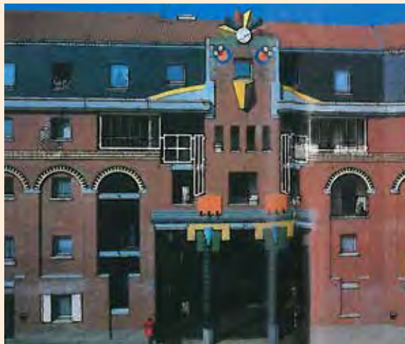
Ce quartier de Roubaix, l'Alma-Gare, est marqué par la prégnance du logement ancien © J.P. Duplan
