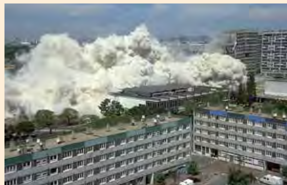
Démolition de la tour des 4 000 à la Courneuve © DRIEA/Gauthier
