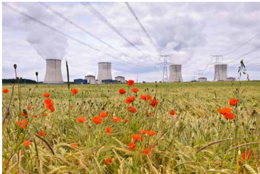
Vue des aéroréfrigérants et bâtiments réacteur de la centrale de Cattenom (Lorraine) © Arnaud Bouissou/Terra
