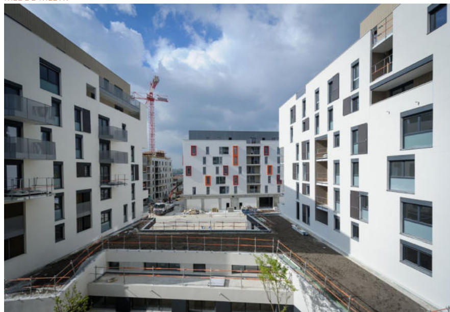
Chantier de construction de 800 logements dans la Zac de la Cerisaie à Fresnes © Arnaud Bouissou / MEDDE-MLETR
