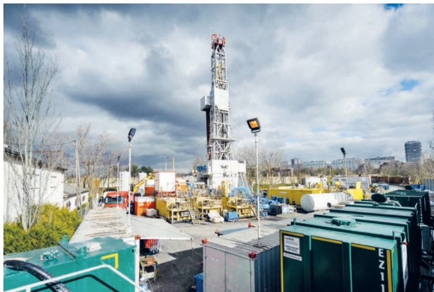
Vue générale du chantier de forage à Gentilly. Les villes d'Arcueil et de Gentilly réalisent un projet de géothermie profonde pour alimenter les deux villes en chaleur (chauffage et eau chaude) © Arnaud Bouissou/MEDDE-MLETR
