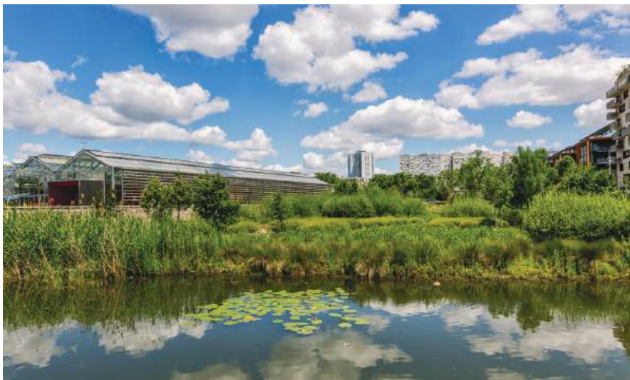
EcoQuartier des Docks à Saint-Ouen, crédits photo @LULU IMAGES (Studio LA MECANOWEB)
