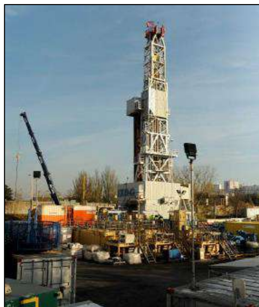
Figure 22 : Forage de puits - Gentilly
