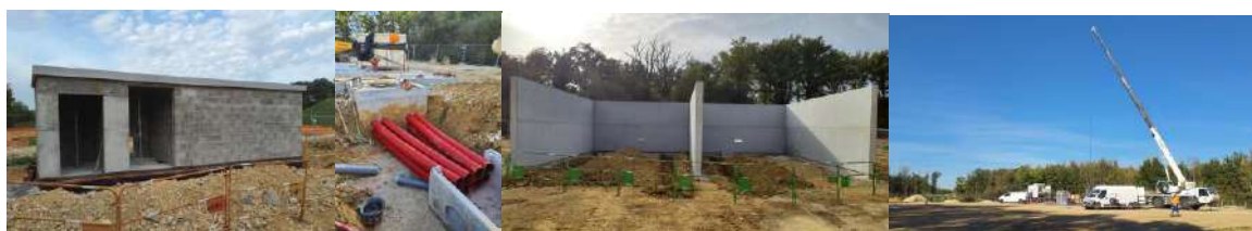
Figure 18 : Avancement des travaux du projet HyPSTER Novembre 2022 (de G. à D. : local supervision de la production H 2 , réseaux enterrés, murs pare-feu des platines de chargement des camions, mesures prévisionnelles dans le puits EZ53).
