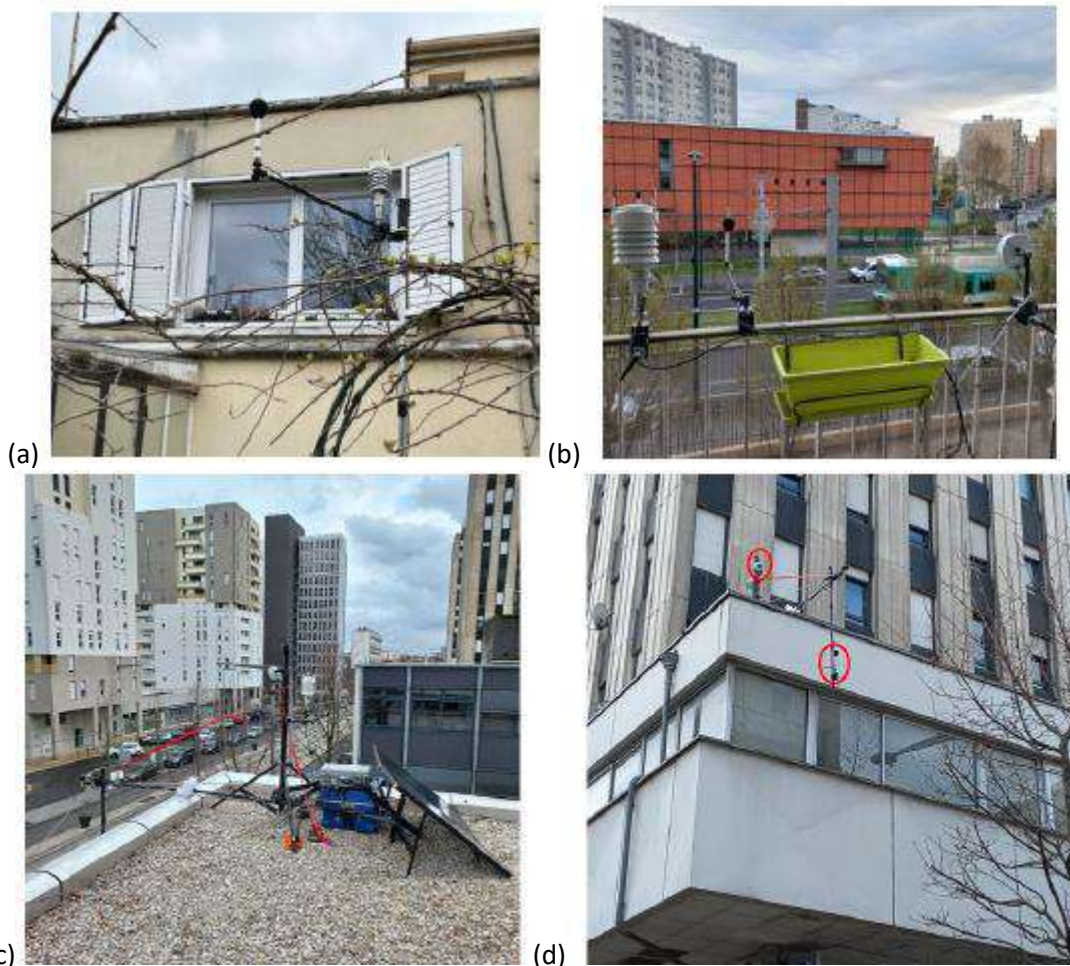
Figure 8: Points de mesure en façade des bâtiments (a : Créteil, b : Asnières, c et d sur bâtiment administratif à Sarcelles) – Source RATP
