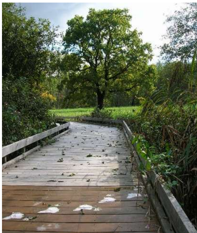
Sentier revêtu d'un platelage bois perpendiculaire, large et sécurisé par des chasse-roues de chaque côté du cheminement – RN du Bout du Lac d'Annecy - @Conservatoire d'espaces naturels Haute-Savoie
