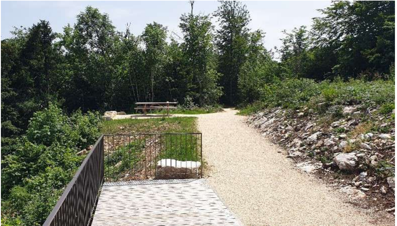
Sol du sentier du Belvédère (forêt domaniale de Clergeon) recouvert d'un revêtement drainant (géotextile, couche de semi-concassé) - ©A. Guézou (ONF)
