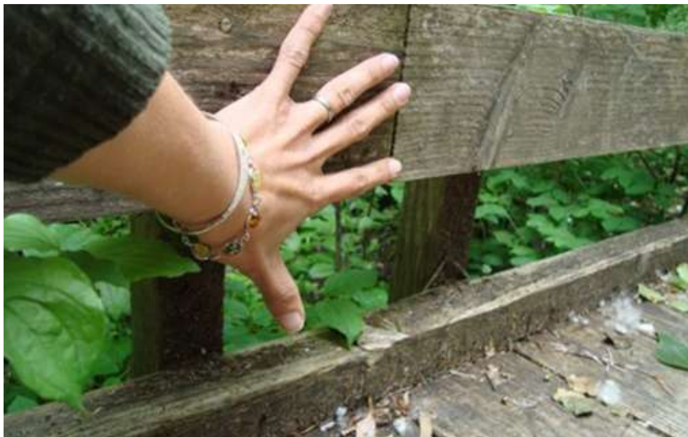
Platelage bordé d'un fil d'Ariane composé d'un chasse-roie et d'une lisse, RN du Bout du Lac d'Annecy – ©Asters
