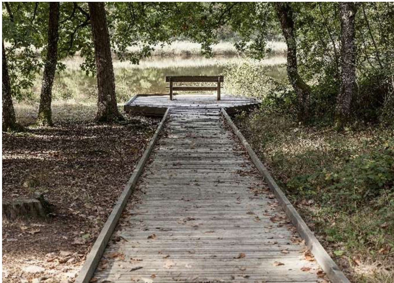
Platelage équipé d'un chasse-roie servant également de fil d'Ariane – ©ONF
