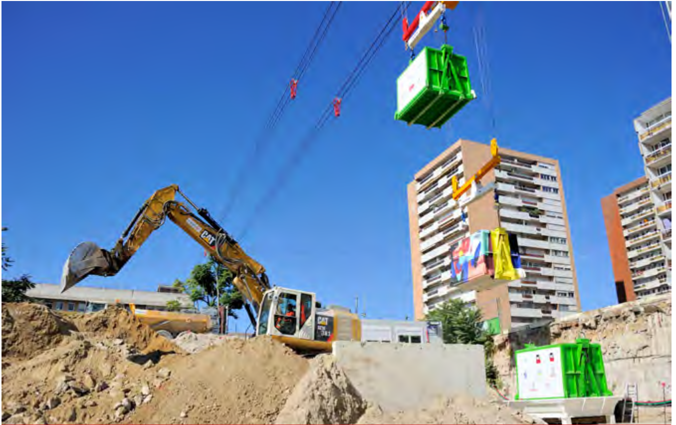
Terrassement et évacuation des gravats
