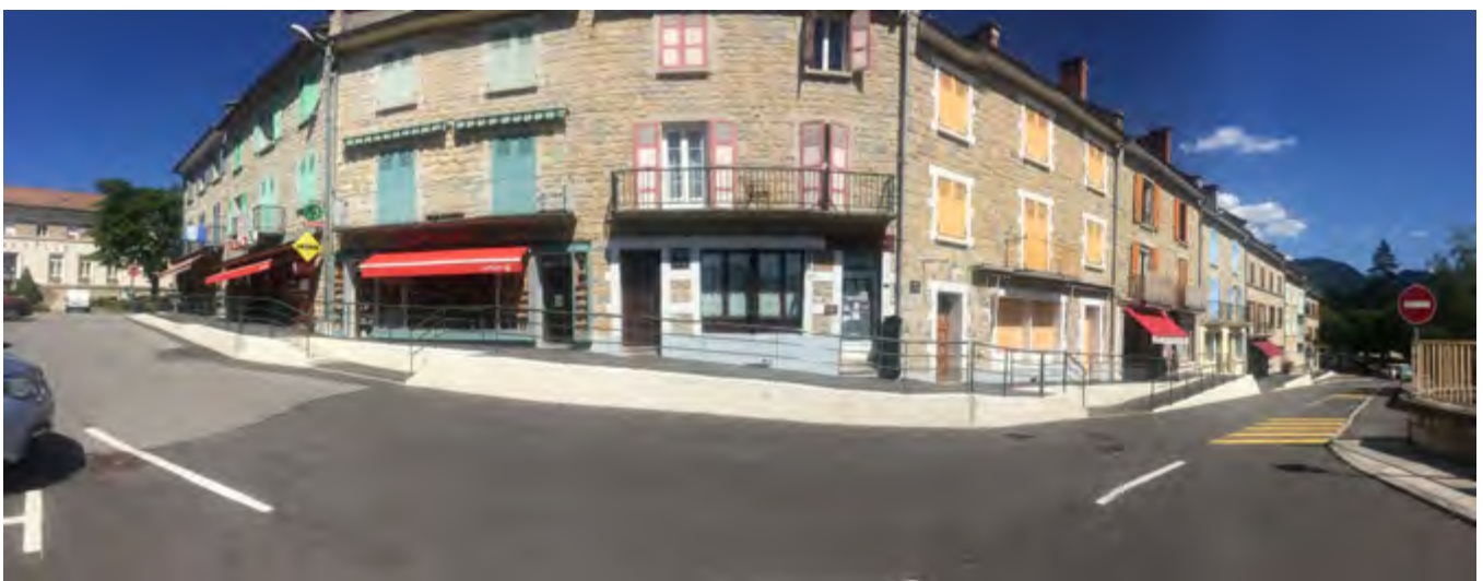
L'avenue des Terrasses après travaux
