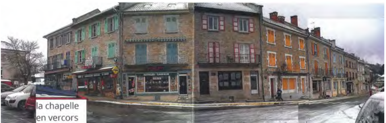
L'avenue des Terrasses avant travaux
