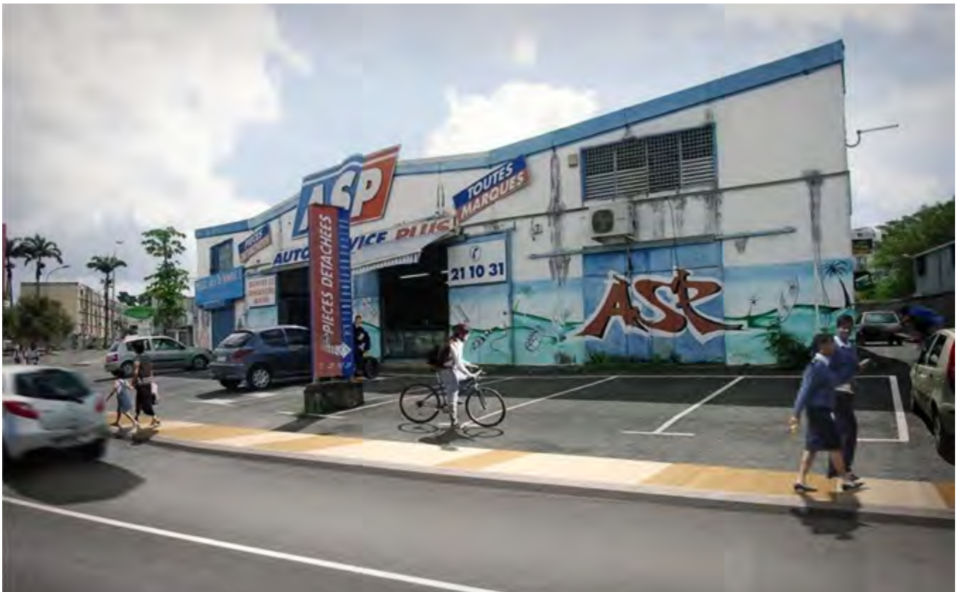
Des cheminements piétons mieux structurés et plus sûrs après 12 mois de travaux
