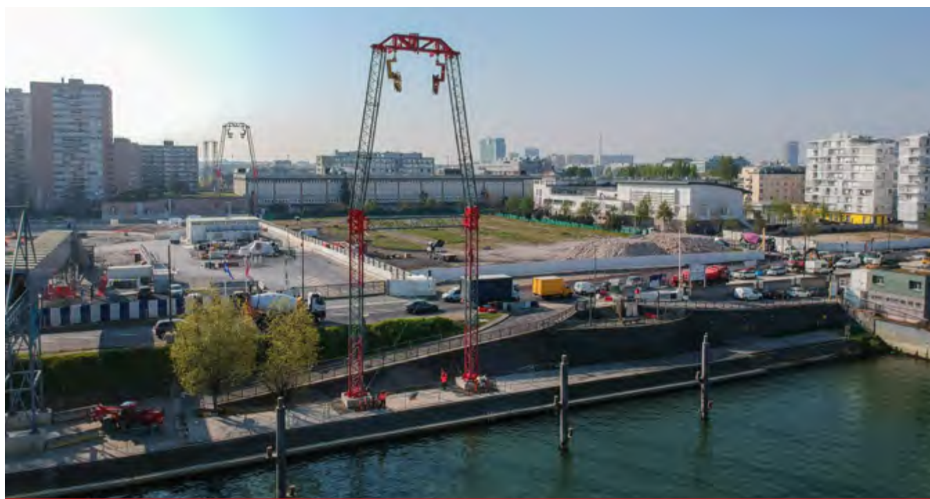
Montage de la grue d'évacuation des gravats
