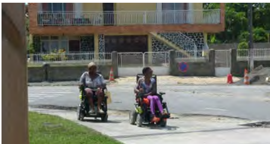
Boulevard de la Rénovation, traité en béton stabilisé, il permet aux utilisateurs de fauteuil roulant de circuler sans vibration
