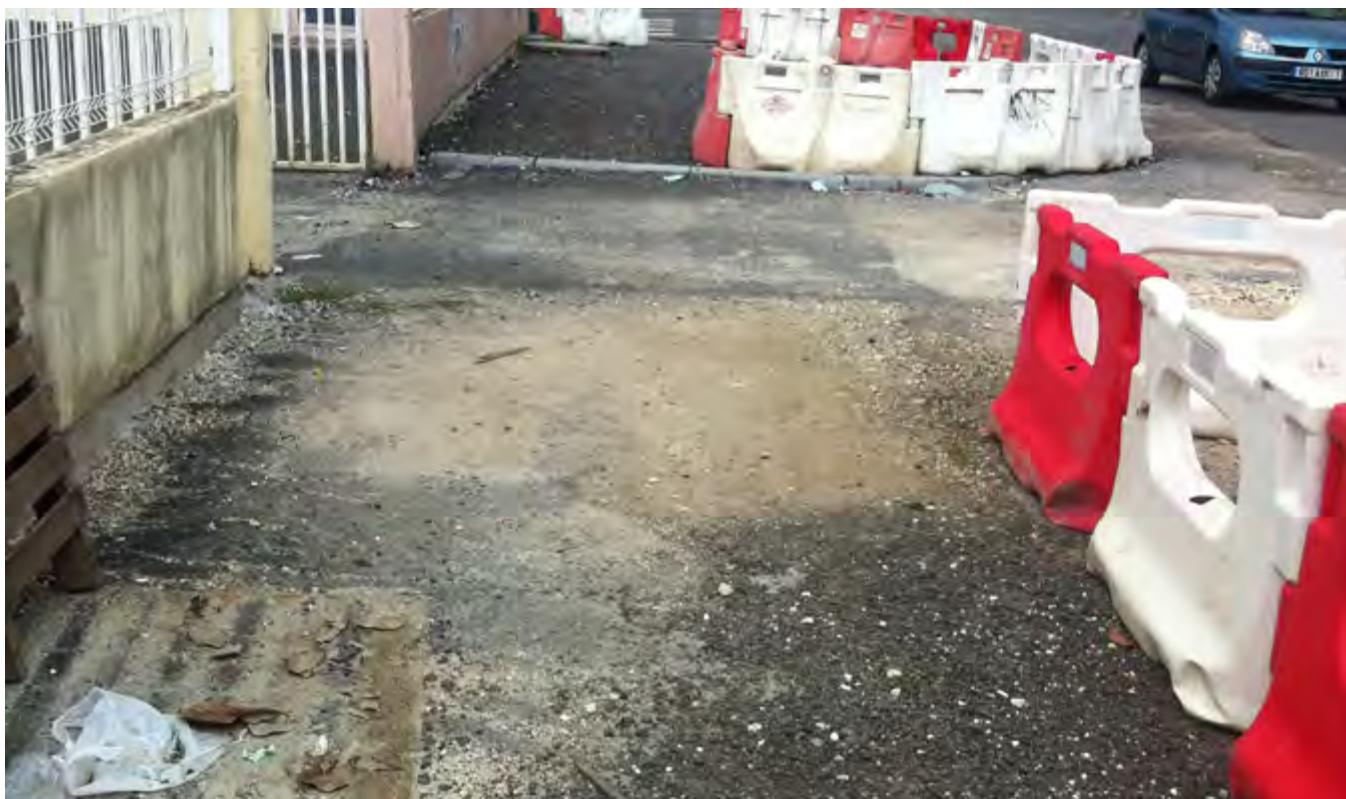
Protection des piétons durant la phase travaux
