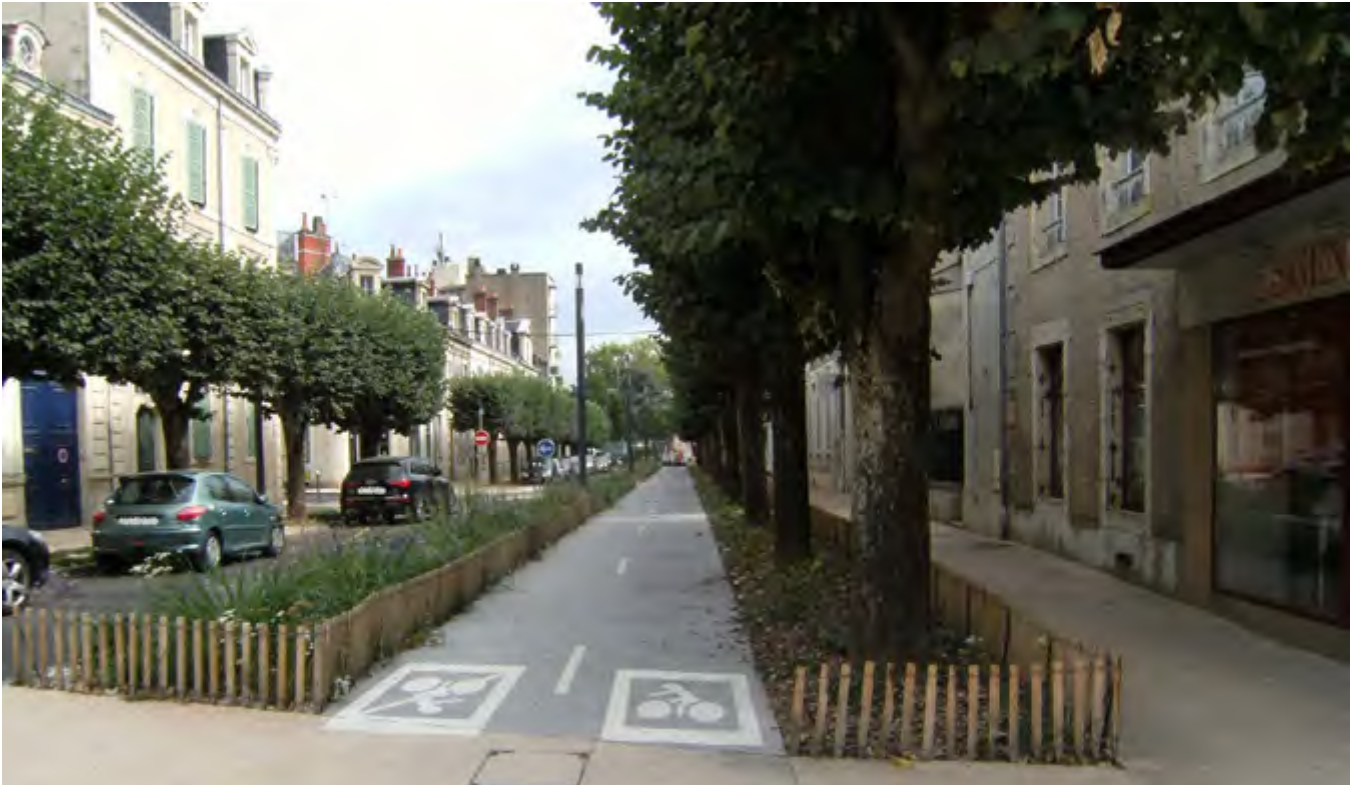
Avenue Pierre Bérégovoy après travaux et avec pistes cyclables
