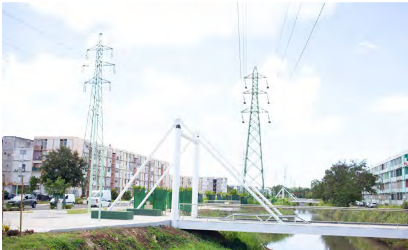
De nouvelles passerelles accessibles et bien repérables, pour les personnes déficientes visuelles, avec des gardes-corps bien dimensionnés
