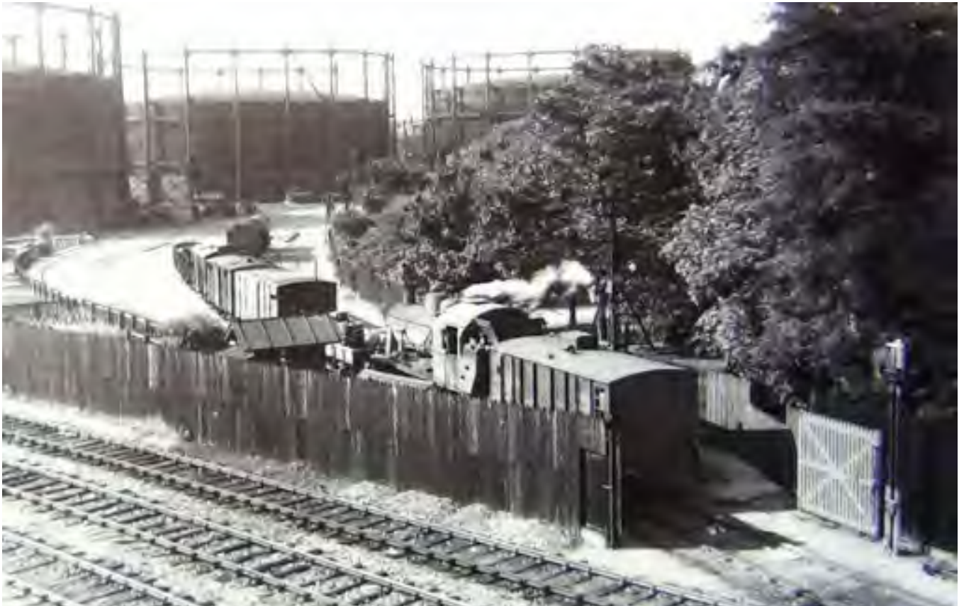
Hier, le site de l'usine à gaz
