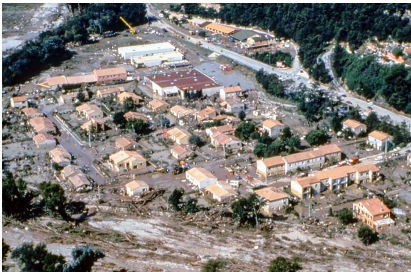
Illustration 2 : crue de l'Ouvèze à Vaison-la-Romaine en 1992 - Photo SDIS 84, source Cyprès.
