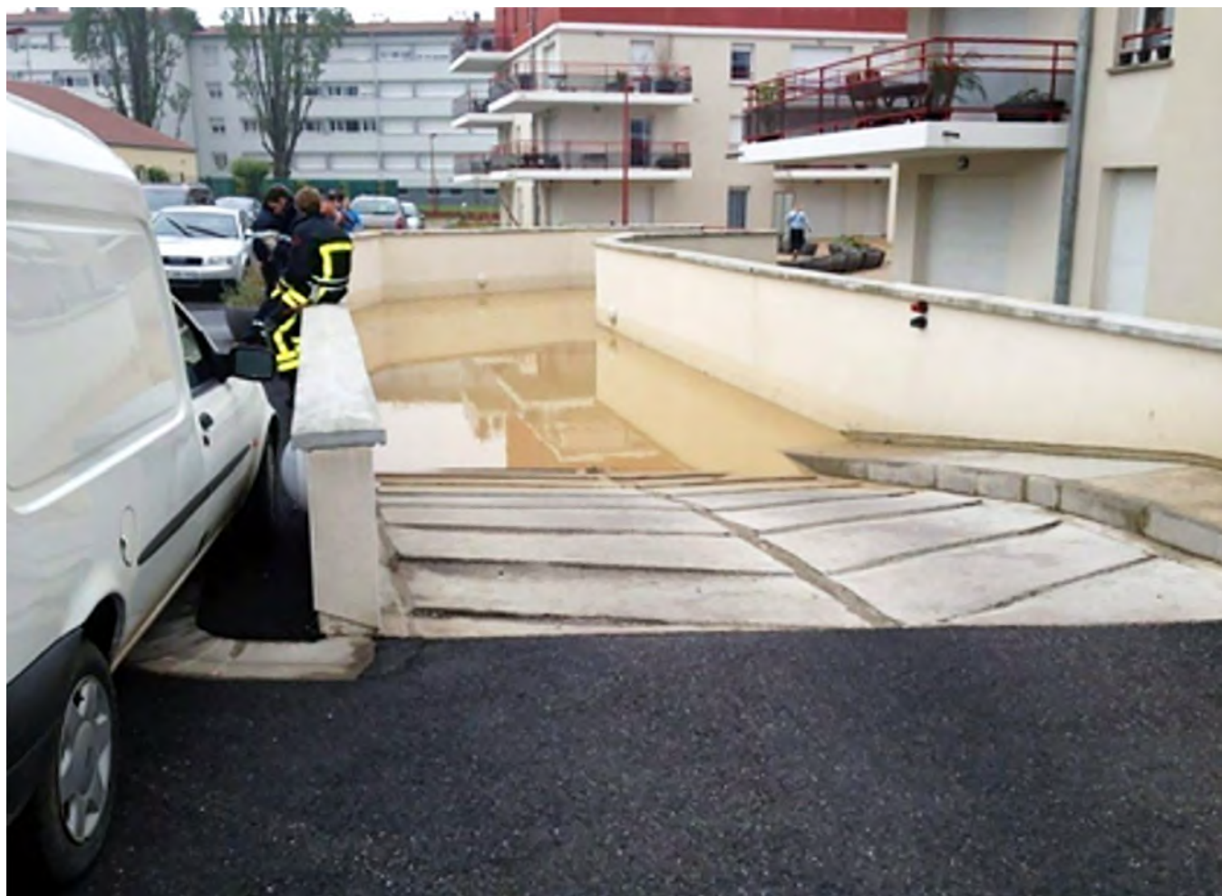
Illustration 38 : inondation d'un parking souterrain en Meurthe-et-Moselle (Grémillon, mai 2012). (Source : Cerema).
