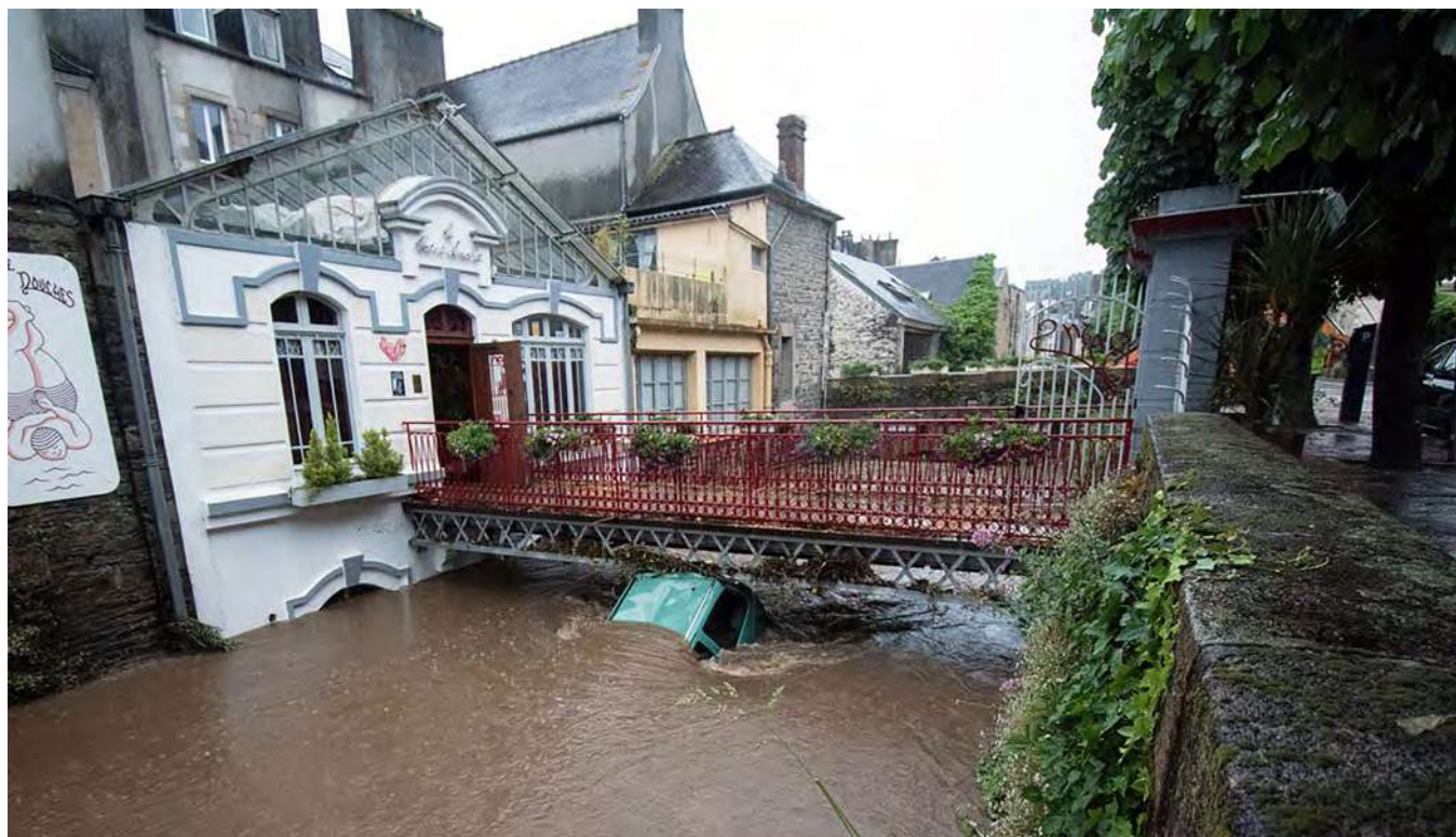
Illustration 20 : création d'embâcles en amont d'un pont à Morlaix en juin 2018 (Source : Morlaix communauté).
