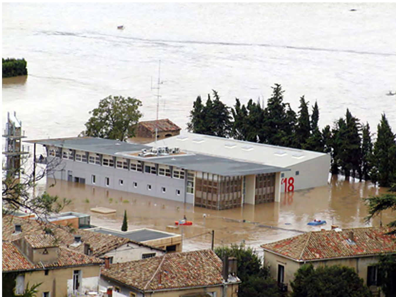
Illustration 3 : caserne des pompiers de Sommières le 9 septembre 2002 - Source : EPTB Vidourle.
