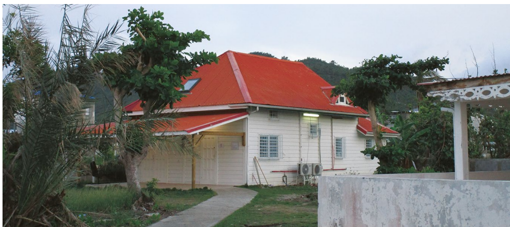
Figure 8 : Auvent de bonne conception car déconnecté de la toiture principale
