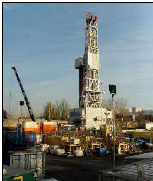
Figure 22 : Forage de puits - Gentilly
