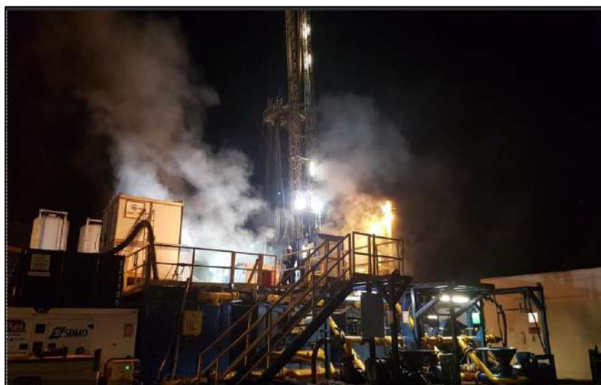
Figure 28 : Plateforme de forage sur le projet PGE à Bordeaux
