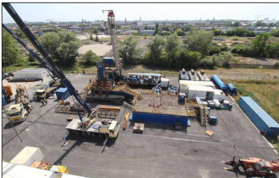
Figure 27 : Préparation plateforme de forage du projet Bordeaux PGE
