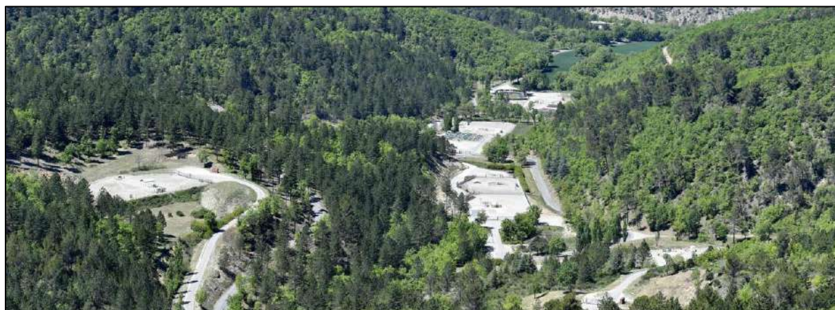
Figure 19 : Vue du site de stockage de gaz de Géométhane à Manosque
