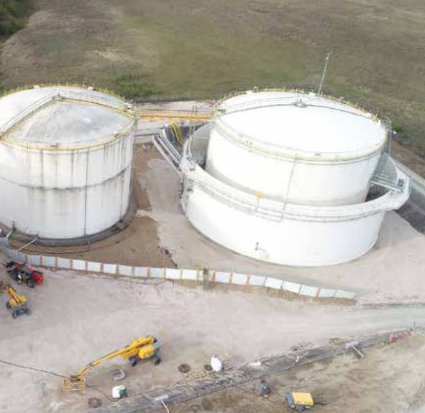
Dépôts de Pétrole d'Orléans Pose de doubles parois autour de deux bacs de stockage d'hydrocarbures à Saint-Jean de Braye (45)
