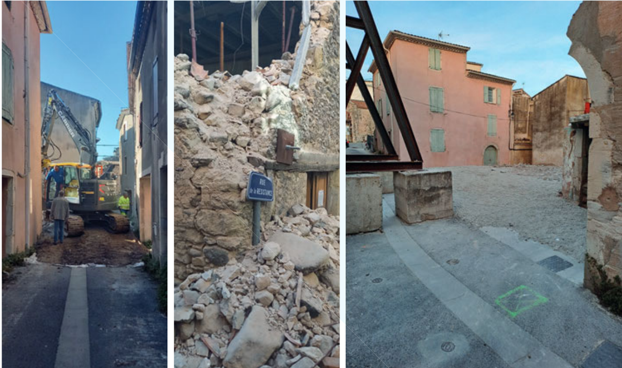
Réhabilitation de l'îlot Mélas Sud en centre-ville du Teillat
