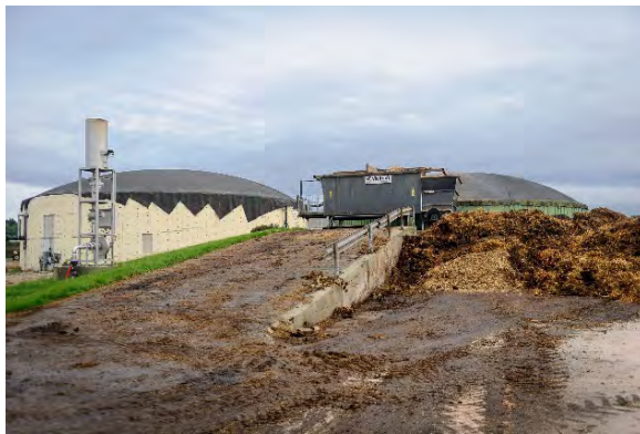
Installation de méthanisation
