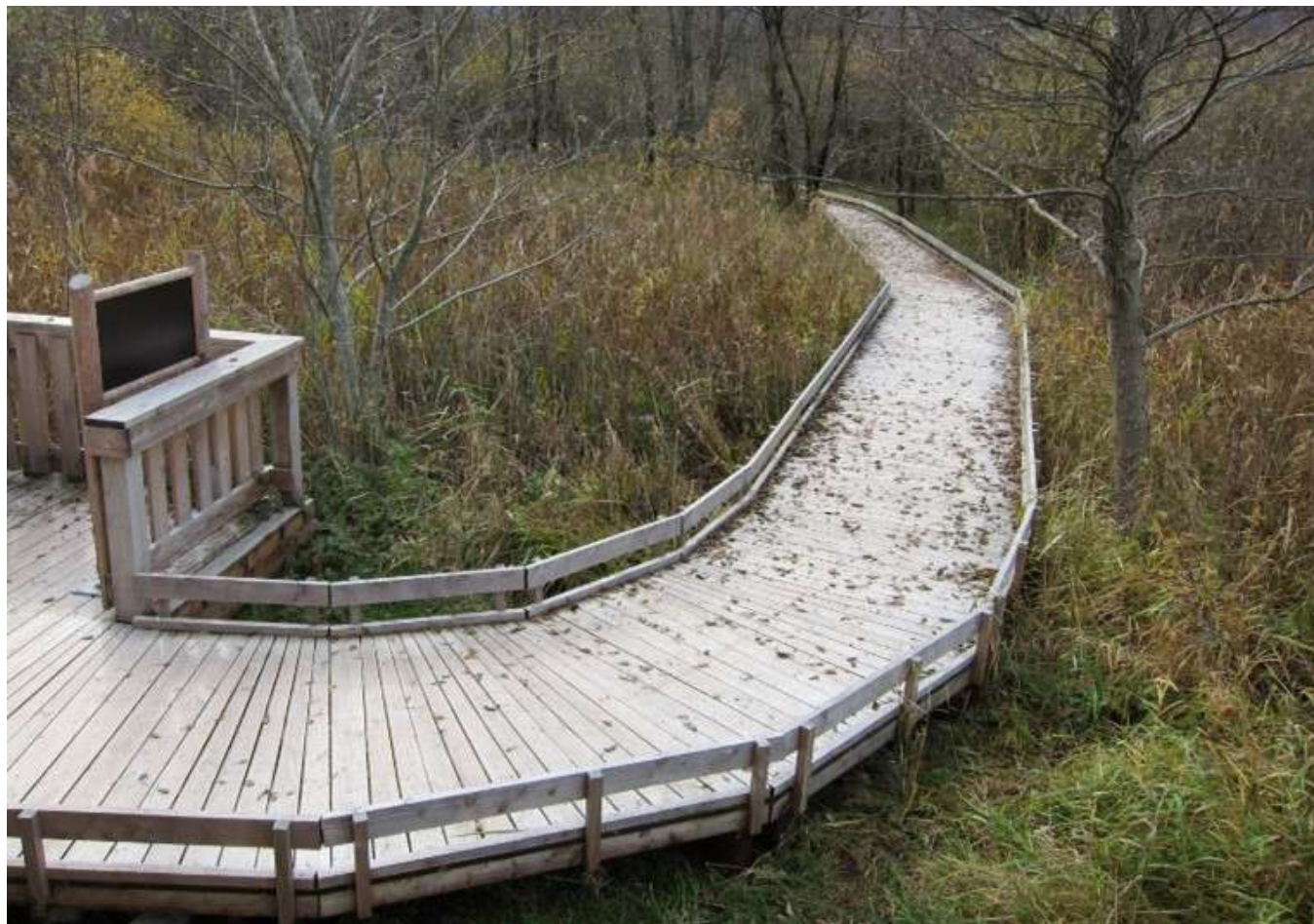
Platelage bois avec des chasse-roues de chaque côté du cheminement, sentier de la réserve naturelle du Bout du Lac d'Annecy, ©A. Guézou (ONF)
