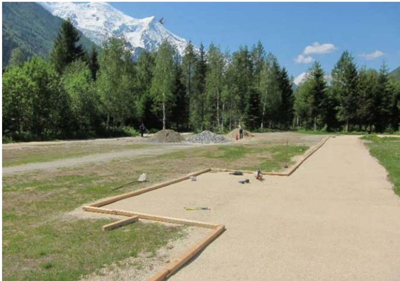
Sol revêtu d'une fine couche de semi-concassé et contrasté avec l'environnement, sentier du Bois du Bouchet (Chamonix) - ©ONF
