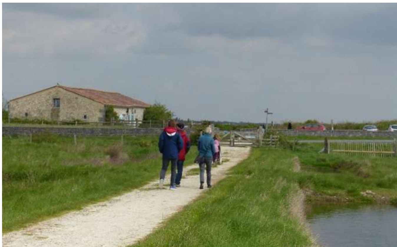
Revêtement en sable stabilisé et surfaces enherbées sur les bas-côtés du cheminement, RNN de Moëze-Oléron – ©LPO
