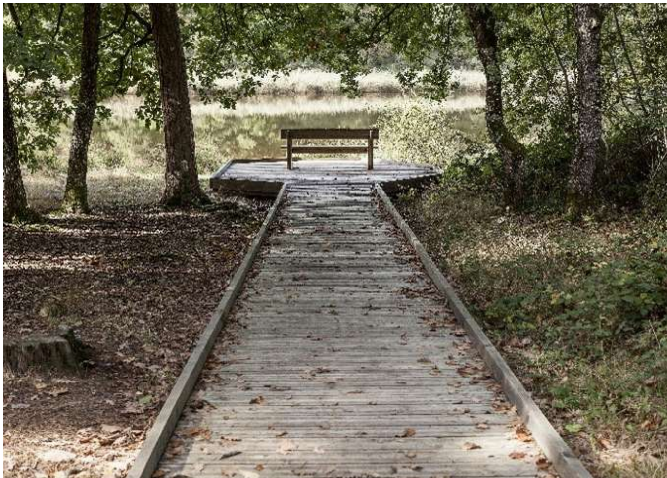
Platelage équipé d'un chasse-roue servant également de fil d'Ariane – ©ONF
