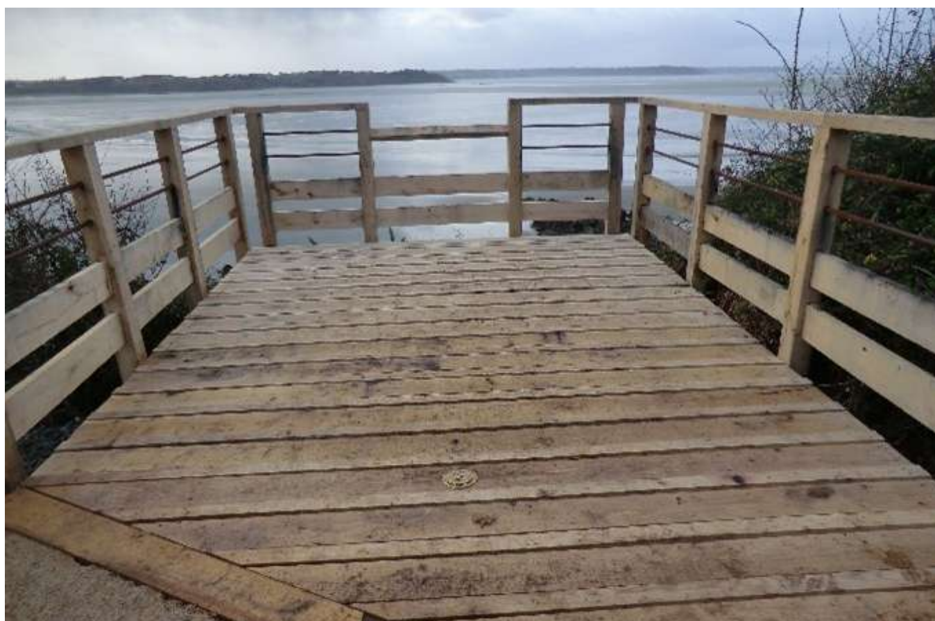
Garde-corps installés sur un belvédère, plage de Béliard (Lamballe-Armor en Penthièvre) - ©Cerema
