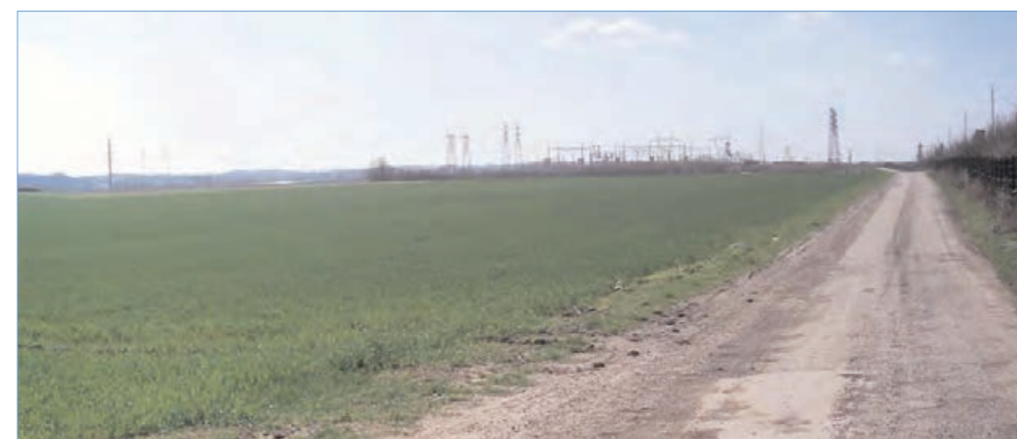
Photographie 30 : vue sur la sous-station électrique depuis son chemin d'accès.
