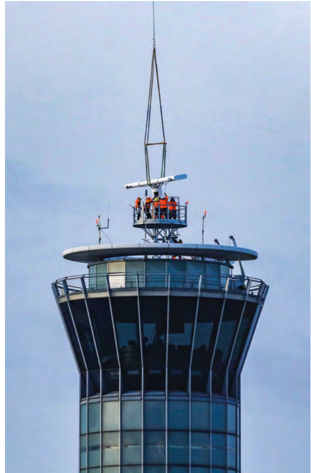
Pose du nouveau radar au sommet de la Tour Nord.
