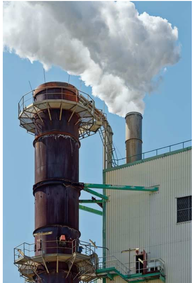
Rejets de fumée par une cheminée industrielle d'une usine de production de pâte à papier et de papier, International Paper, à Saillat-sur-Vienne. Crédit : Thierry Degen / Terra
