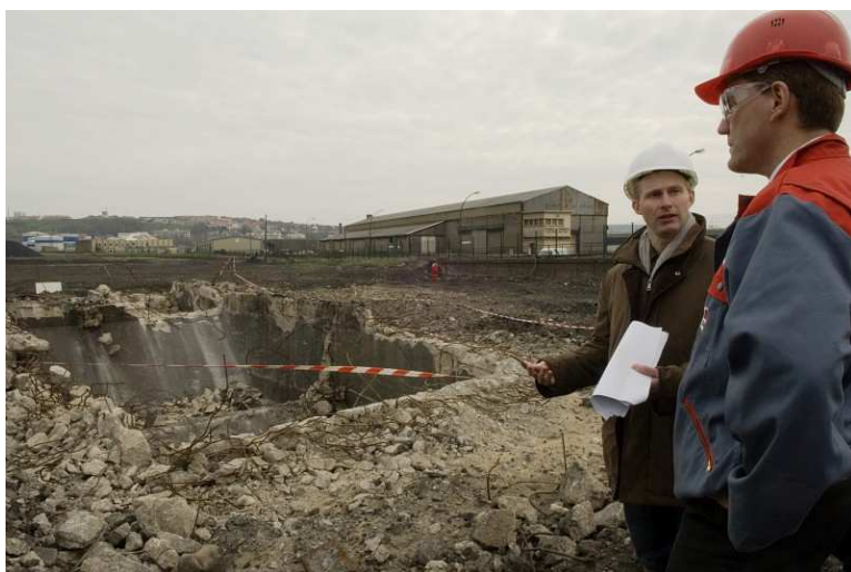
Démantèlement d'un site industriel, visite d'inspection dans le cadre du contrôle des installations classées Crédit : Laurent Mignaux / Terra
