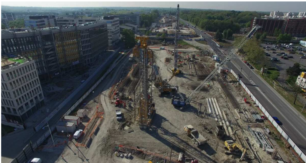
Vue drone des chantiers Noisy-Champs - @ Société du Grand Paris – 1616Prod
