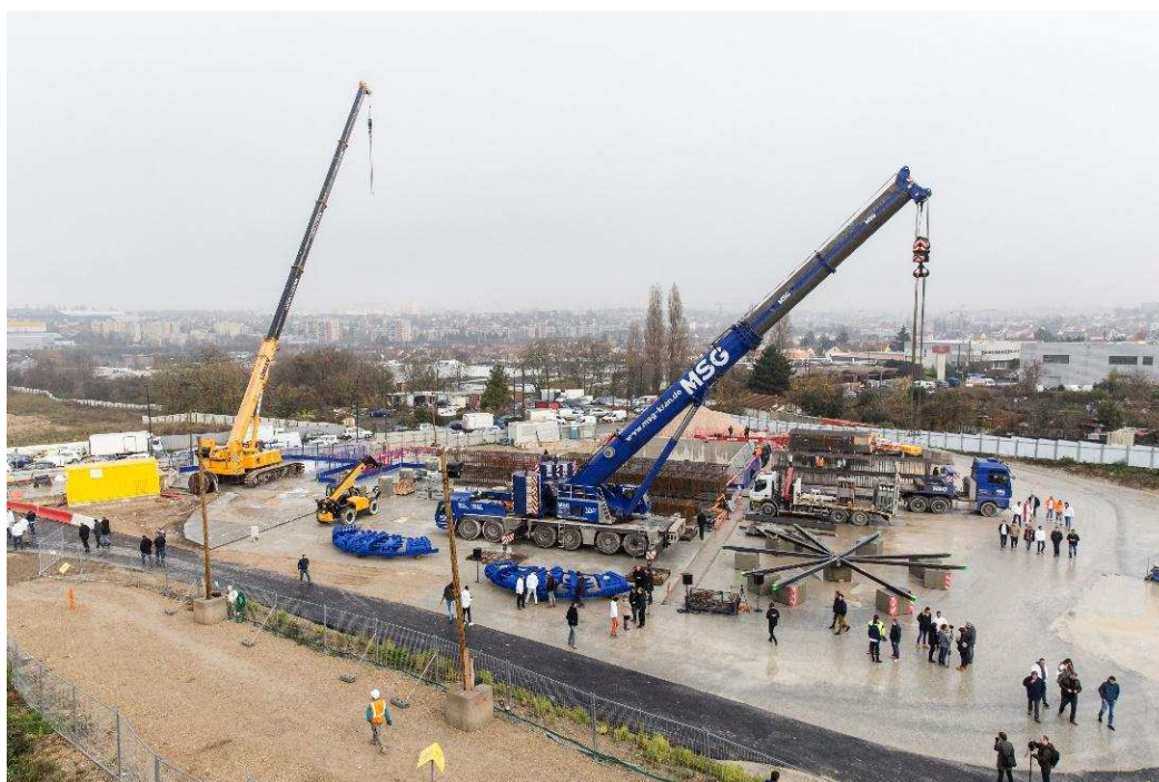
Pièces du premier tunnelier sur le chantier de Champigny plateau - @ Société du Grand paris – Florence Joubert
