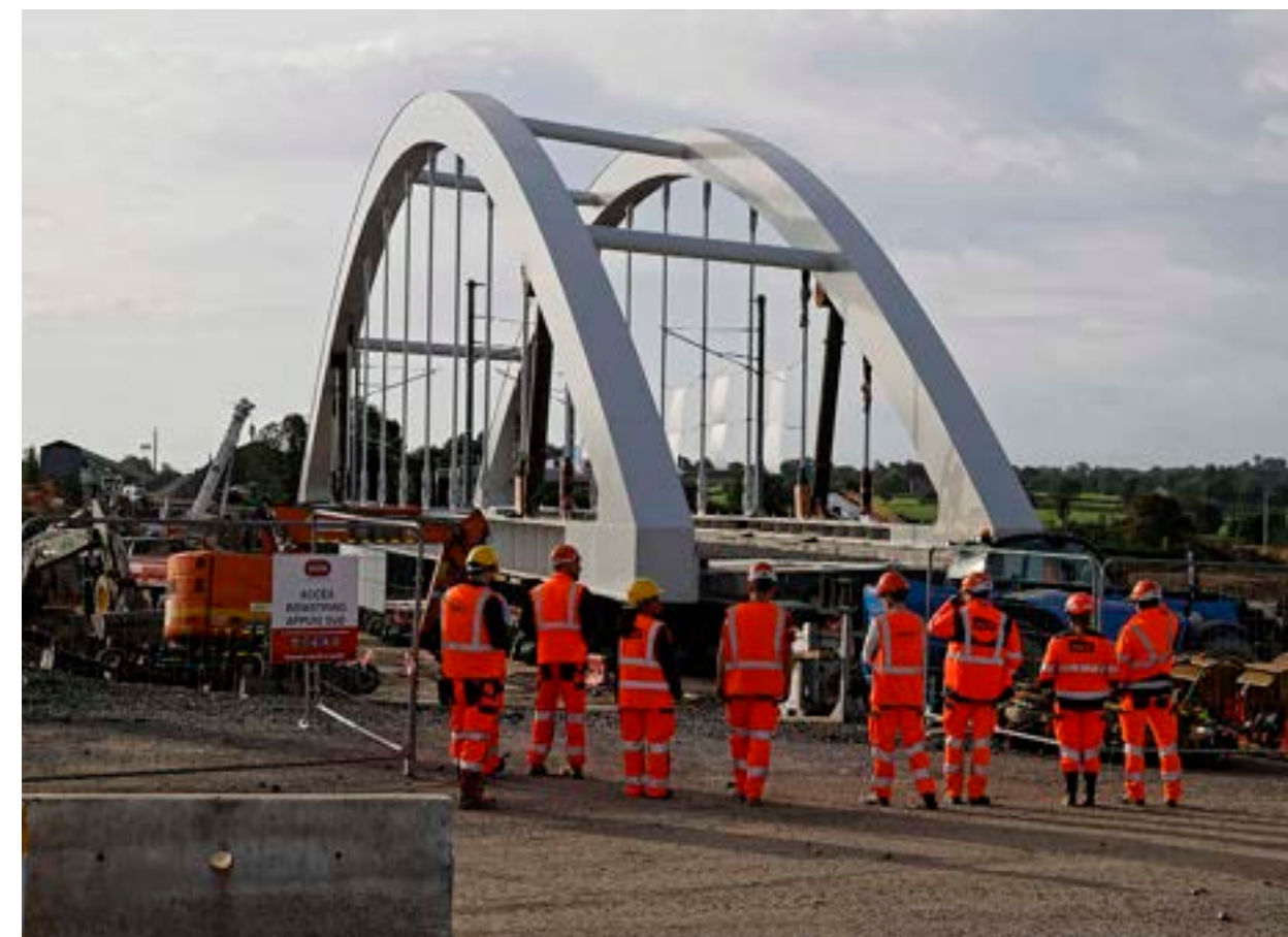
Pont ferroviaire d'Avesnelles - © Région Hauts-de-France / D. Bokalo
