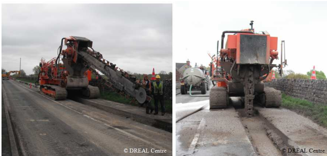
Renforcement du corps de digue à Veuves (Val de Cisse - 41) par la mise en place d'une paroi en mélange
