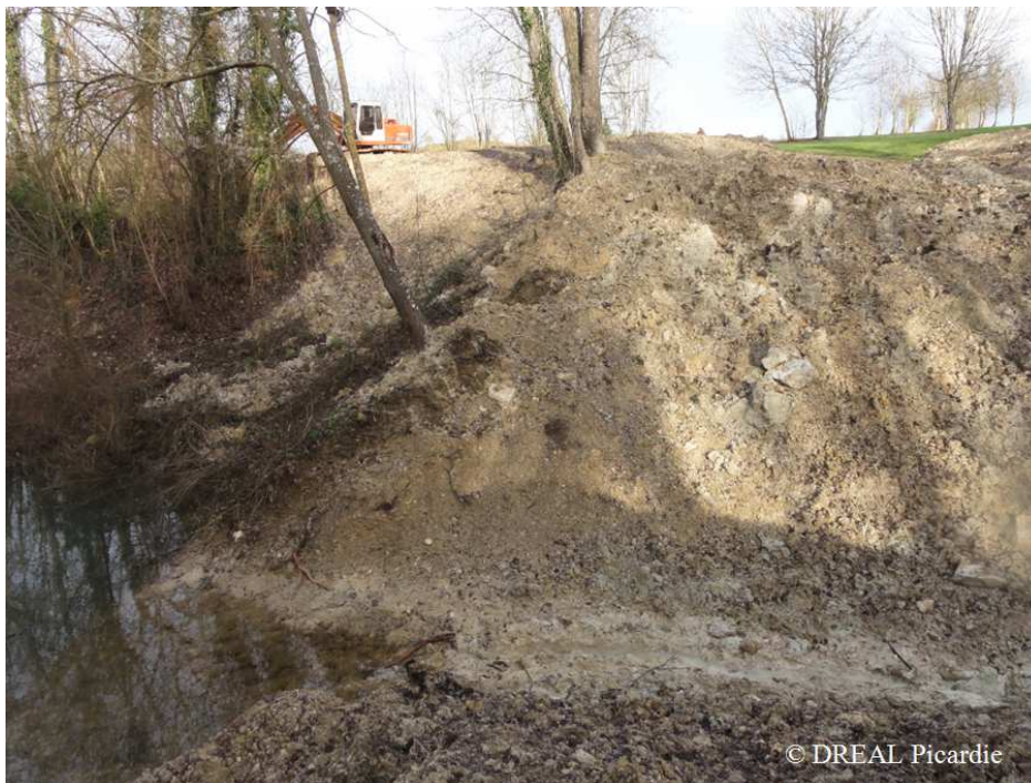
Barrage du Val Secret mis en transparence
