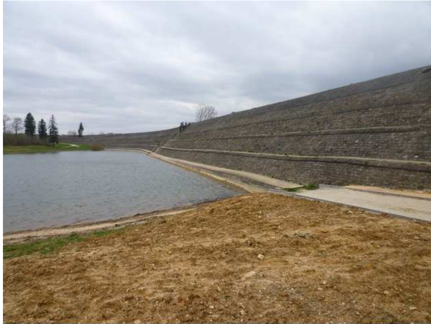
Parement amont du barrage de Leschères
