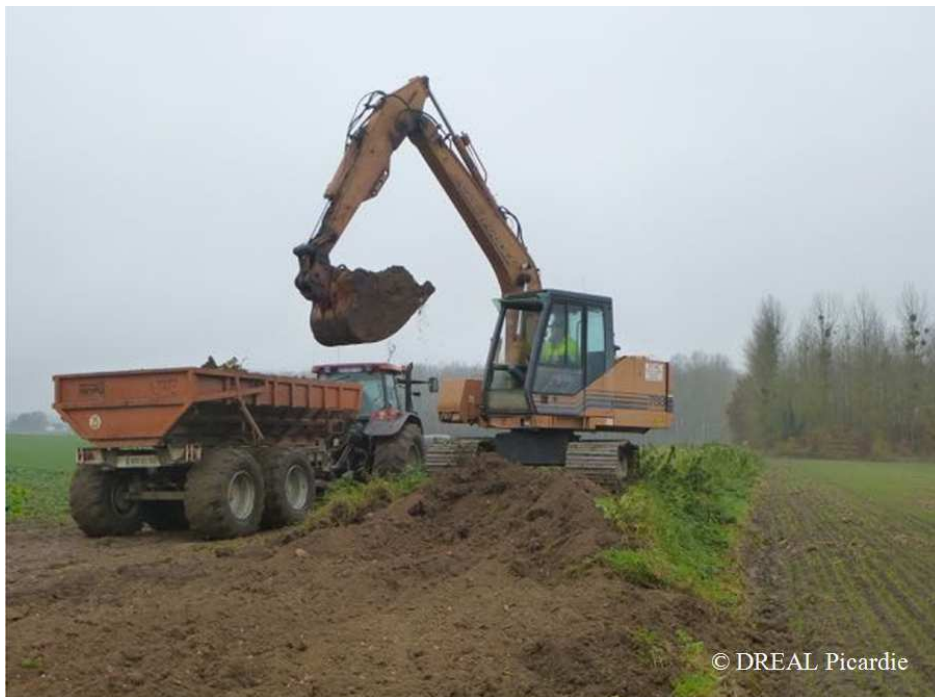
Réalisation des travaux de neutralisation de la digue de Varesnes
