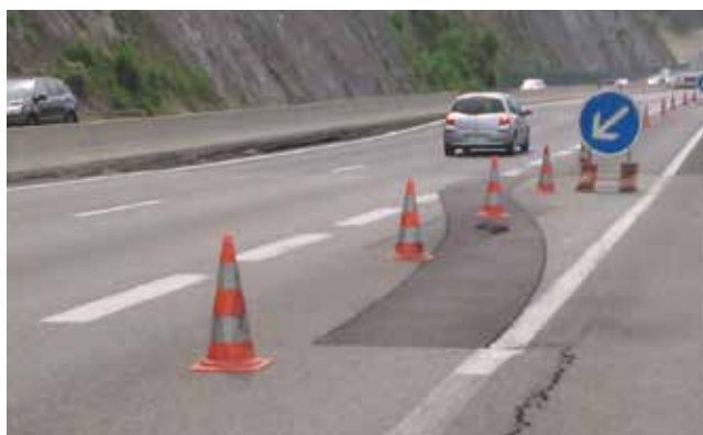
Fissure et déformation de la chaussée nord de l'autoroute A8 dans la zone du glissement
