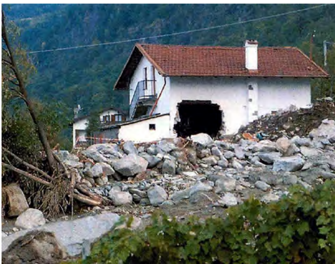
Illustration 51 : façade endommagée par des impacts d'une crue torrentielle (©région autonome Vallée d'Aoste).
