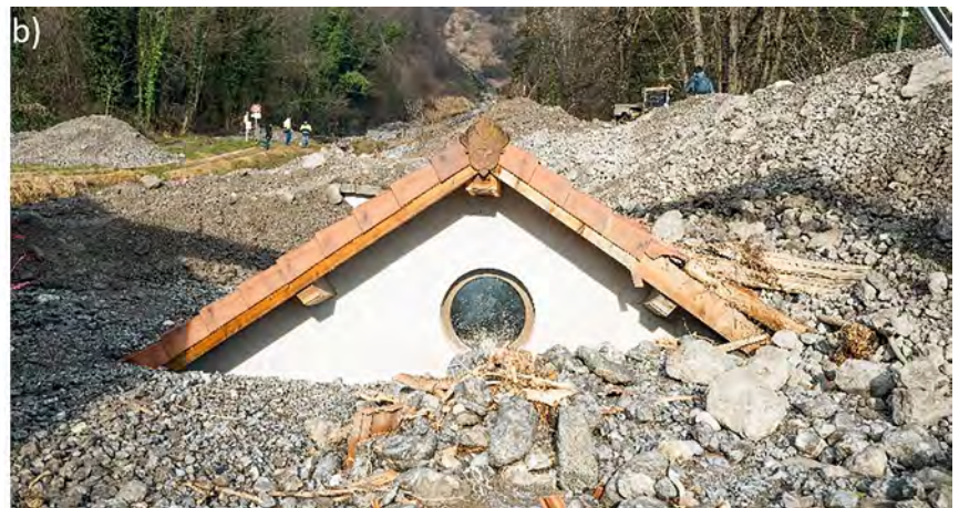
Illustration 24 : engravements - a) par dépôts de lave torrentielle (Modane, Juillet 2014, ©ONF-RTM) et b) par dépôts de charriage (Lumbin, Janvier 2022, ©MOCEAN, O. Lefebvre).
