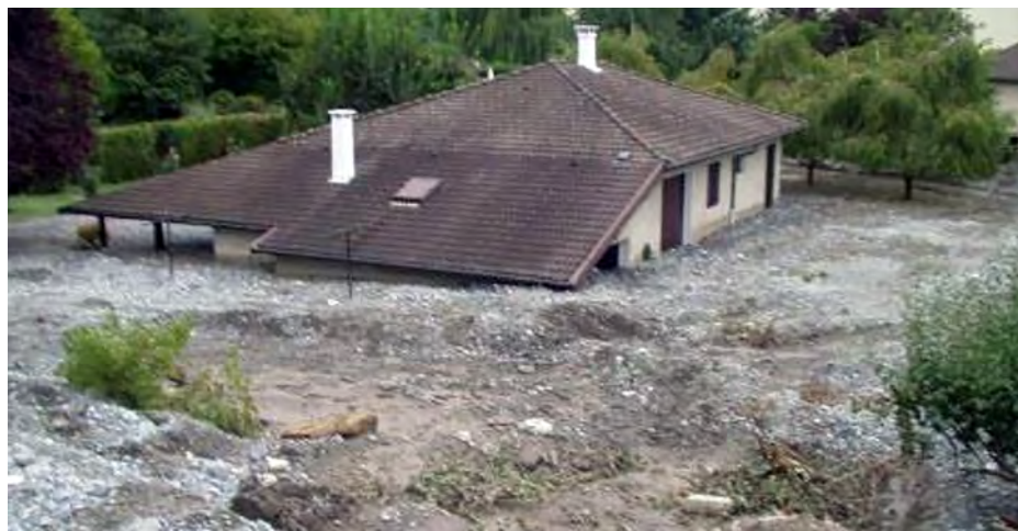
Illustration 64 : maison engravée à la suite d'une brèche dans la digue Torrent du Doménon - Domène (38) - 2005 (©ONF-RTM).
