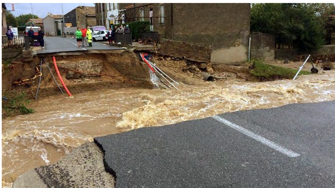
Illustration 1 : la crue du Trapel (affluent de l'Aude) a emporté un pont à Villegailhenc (©AFP, 2018).
