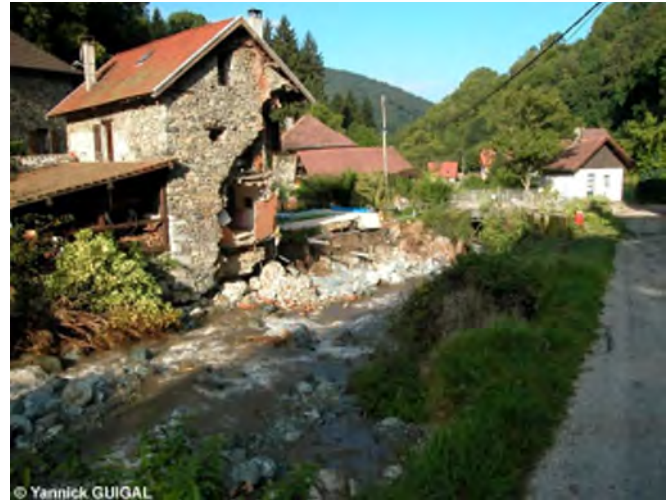
Illustration 23 : dégâts causés à l'angle d'un bâtiment du fait de la concentration des écoulements - Saint Martin d'Uriage, 2005 (© IRMA).
