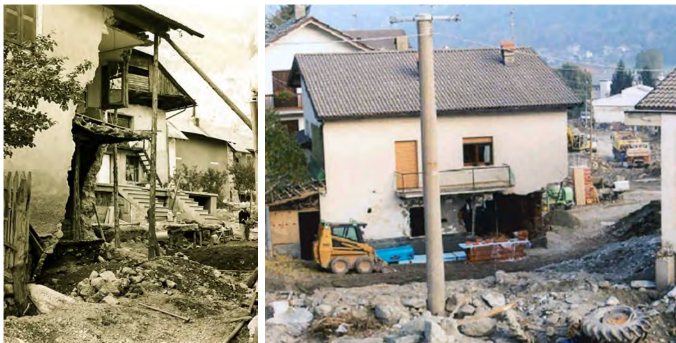
Illustration 44 : exemples d'affouillement des fondations (en particulier au niveau des angles) ©Région autonome Vallée d'Aoste.
