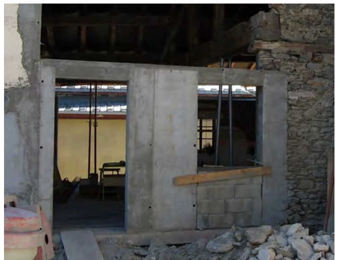
Illustration 52 : reprise des maçonneries d'un bâtiment ancien (©SEPIA Conseils).
