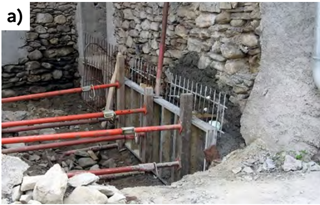
Illustration 45 : exemples de renforcements ou de protection des fondations.
