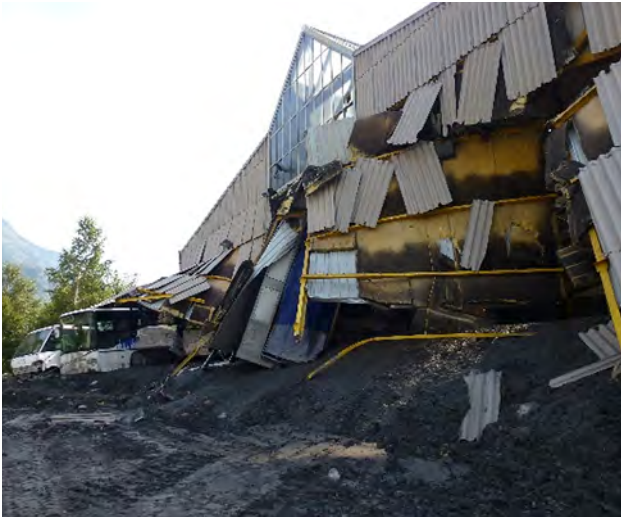
Illustration 25 : dommages provoqués par une lave torrentielle à Modane en juillet 2014 (© INRAE, G.Piton).
