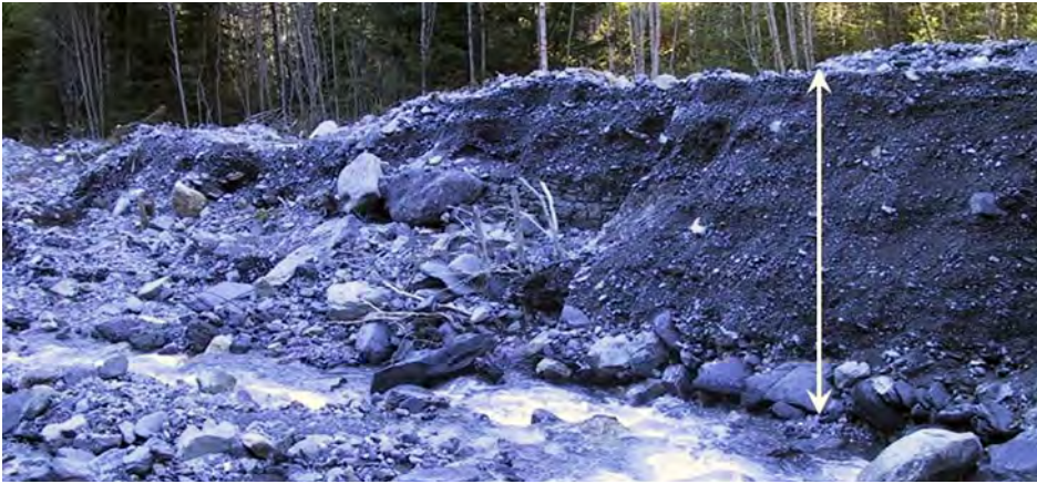
a) très fortes fluctuations du niveau du fond de lit à la sortie des gorges, en amont de la zone alluvionnaire (©ETRM)
