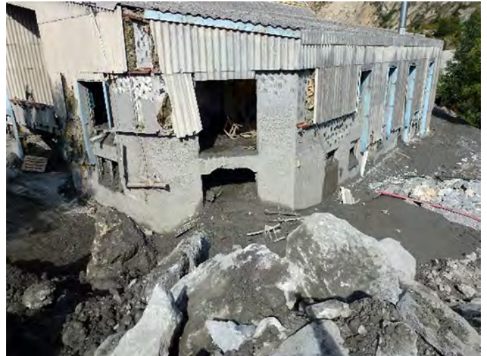
Illustration 25 : dommages provoqués par une lave torrentielle à Modane en juillet 2014 (© INRAE, G.Piton).
