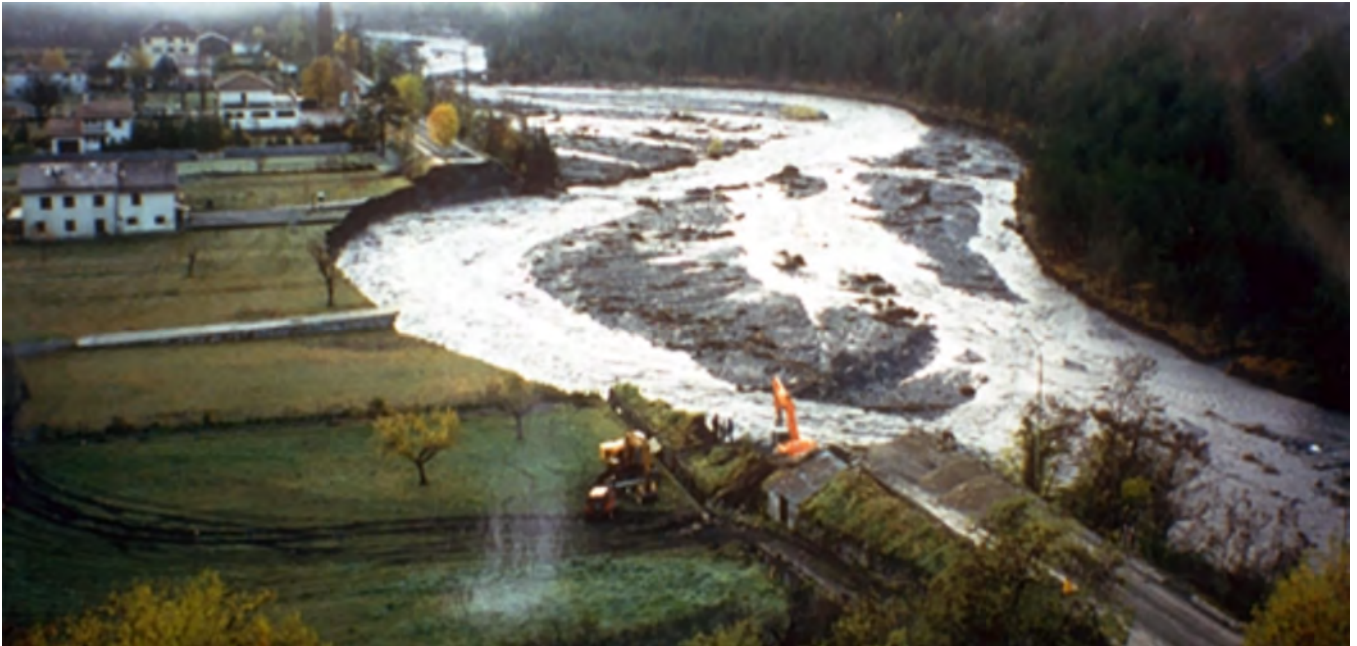
Illustration 30 : large brèche due à une érosion externe sans débordement - Var - Guillaumes (06) - 1994 (©ONF).
